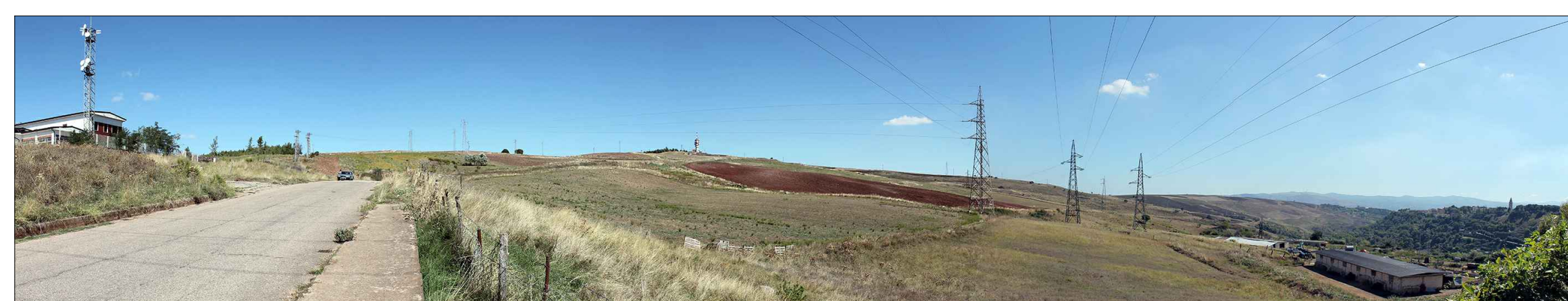
PAN 03 _ Vista dalla SP 111 in prossimità della Cabina Primaria di Melfi; il traliccio n. 31 è il secondo da destra .
