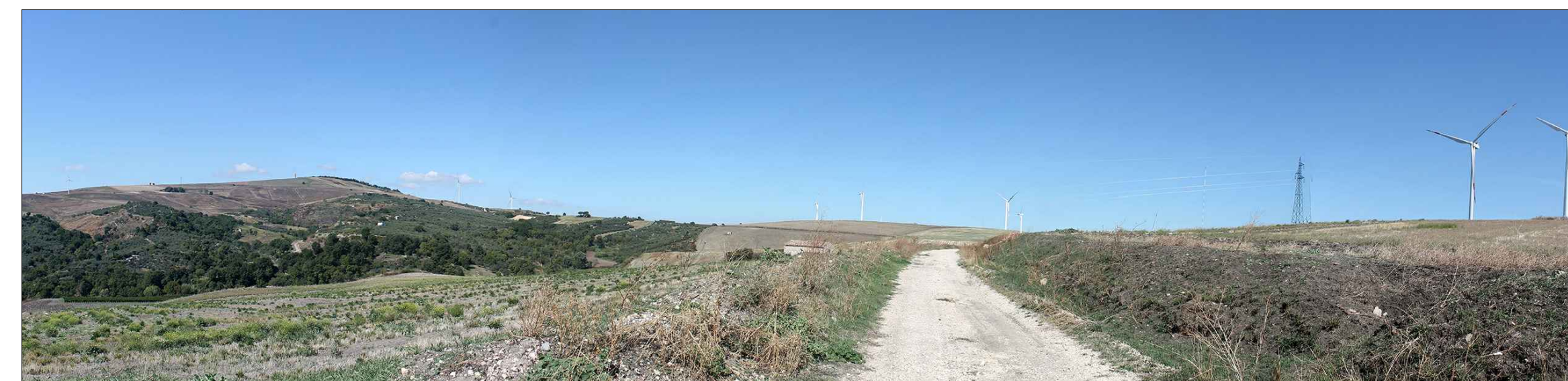
PAN 07 _ Vista dell'elettrodotto nei pressi della SP 111 , in corrispondenza dell'attraversamento del Vallone di Macera.
