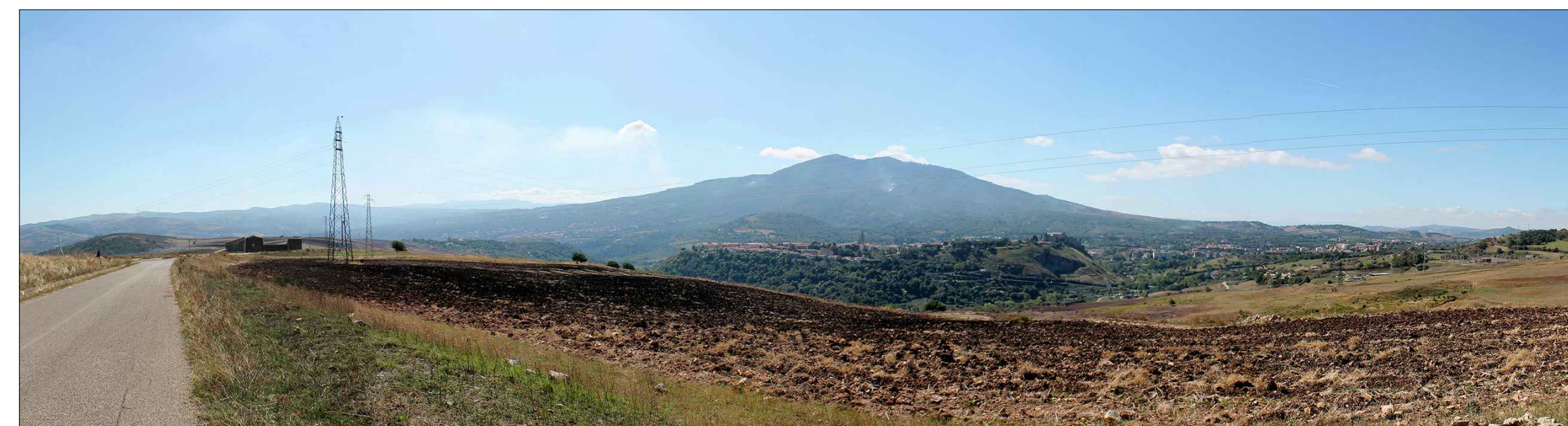
PAN 05 _ Vista dalla SP 111 verso la Cabina Primaria di Melfi; in primo piano il traliccio n. 28. Al centro l'abitato di Melfi e il castello, e sullo sfondo il Vulture.
