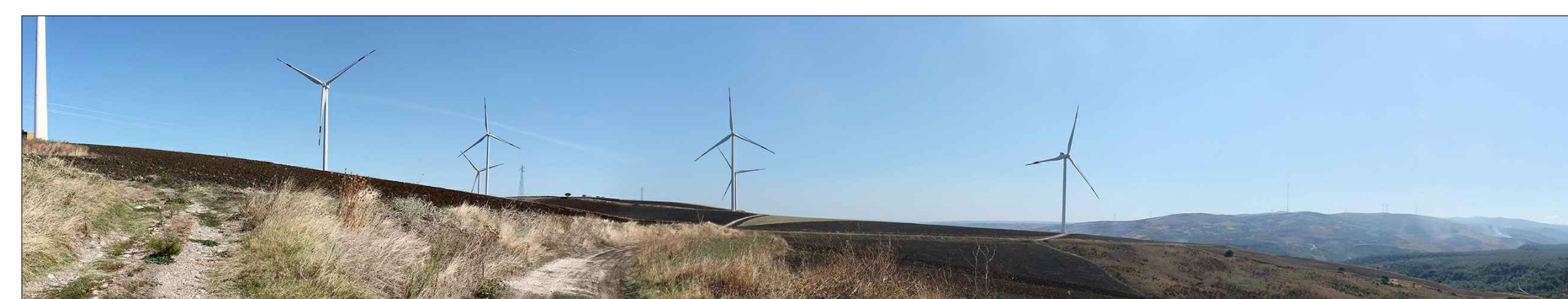
PAN 09 _ Vista dell'elettrodotto in prossimità del parco eolico di Albero Piano.
