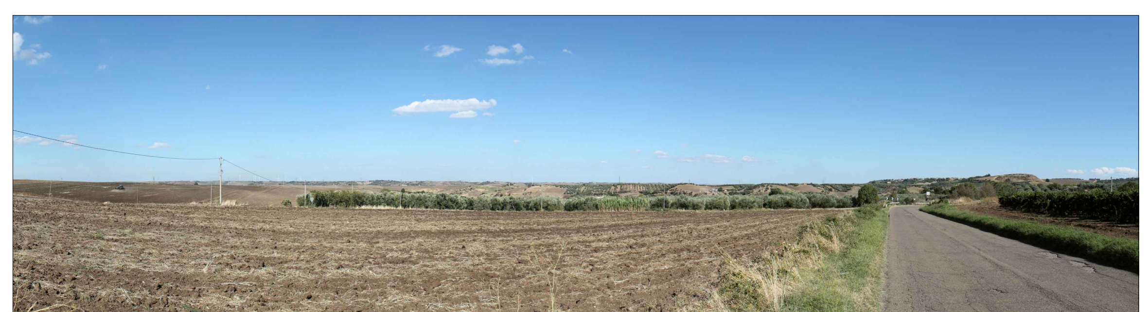
PAN 11 _ Vista dell'elettrodotto dalla SS 168. Sullo sfondo, il centro abitato di Venosa.
