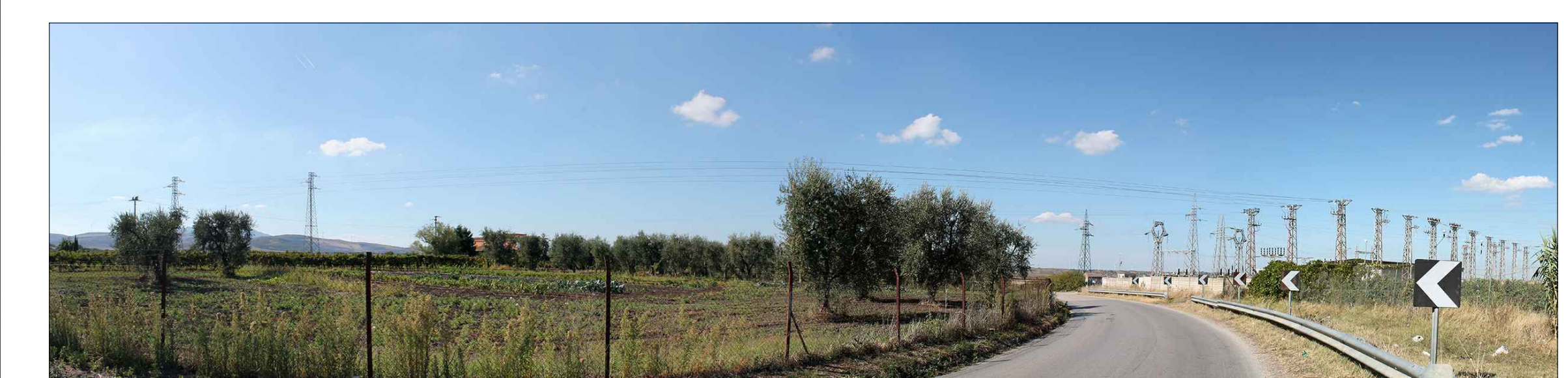
PAN 13 _ Vista dalla SP 109 dei tralicci n 1-2-3 in uscita dalla Cabina Primaria di Venosa
