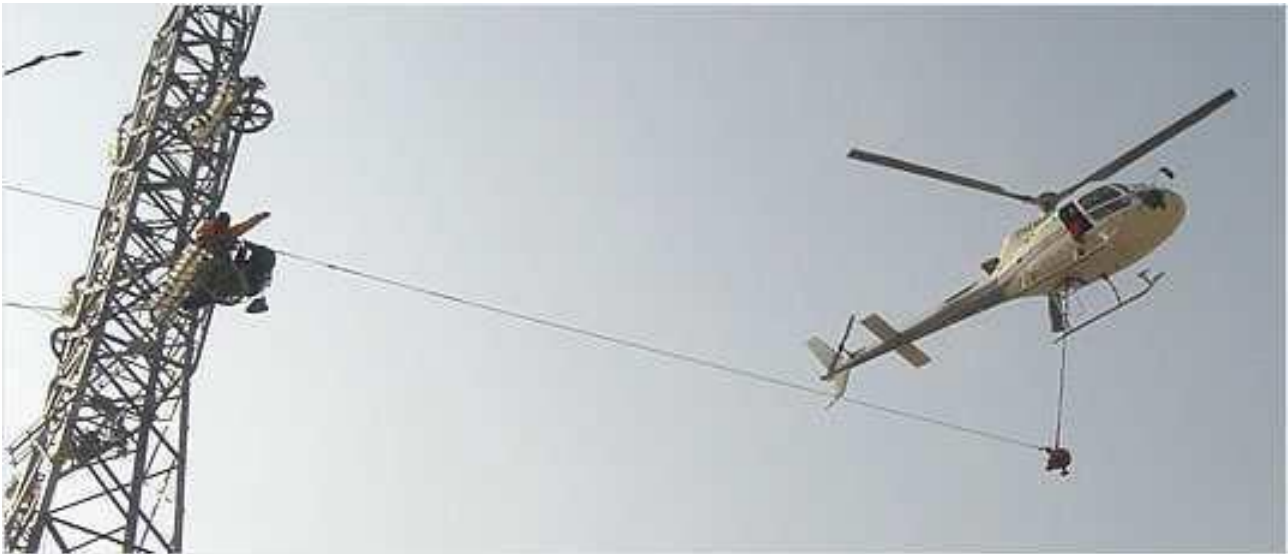
Figura 11 – Esempio stendimento conduttore con l’ausilio dell’elicottero
