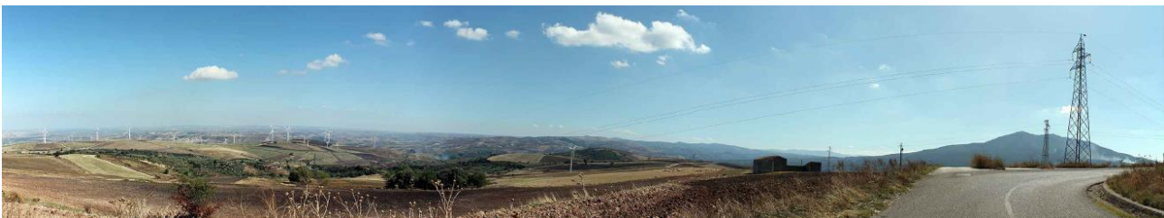
Figura 7 – Vista dell'elettrodotto in prossimità del traliccio N°28 dalla SP111
