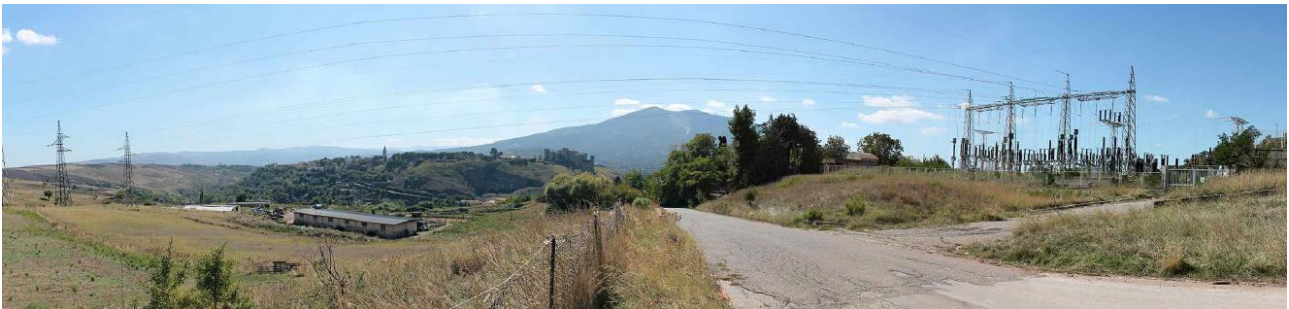
Figura 6 – Vista dell'elettrodotto in prossimità della cabina primaria di Melfi
