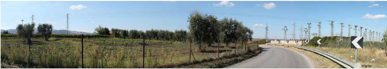
Figura 5 – Vista dell'elettrodotto in prossimità della cabina primaria di Venosa
