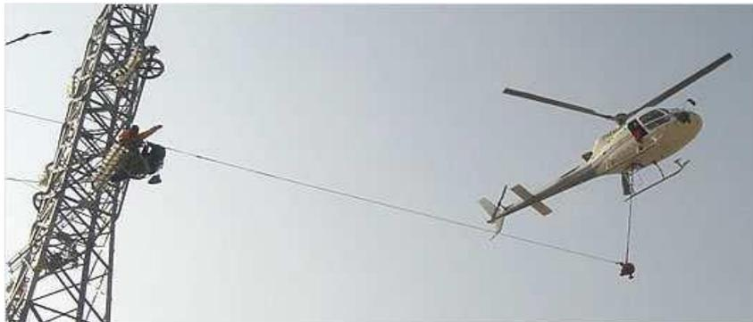
Figura 8: Esempio stendimento conduttore con l'ausilio dell'elicottero
