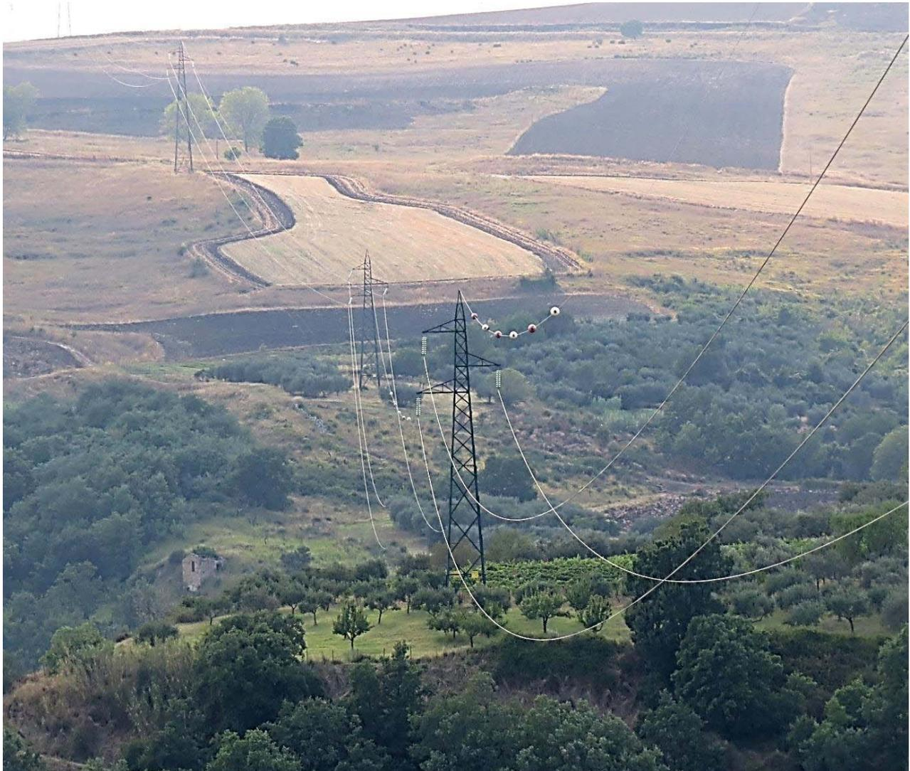
**Figura 5:** Vista della sequenza di tralicci 26-27-28 esistenti, proseguendo dalla CP Venosa verso la CP Melfi, in prossimità del Vallone di Macera; i tralicci sono del tipo “Semplice Terna” di altezza variabile compresa tra 15 e i 30 m.
