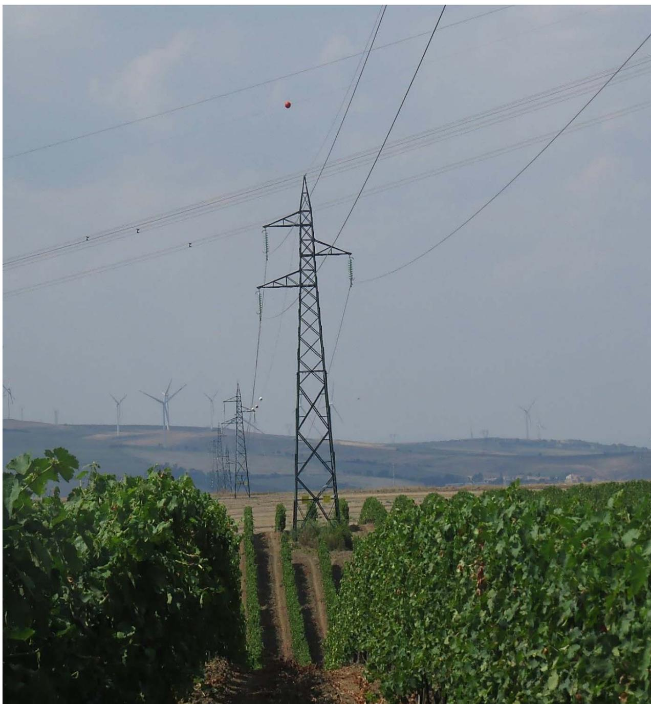
**Figura 4: Vista della sequenza di tralicci 8-9-10-11 esistenti, proseguendo dalla CP Venosa verso la CP Melfi; i tralicci sono del tipo "Semplice Terna" di altezza variabile compresa tra 15 e 30 m.**
