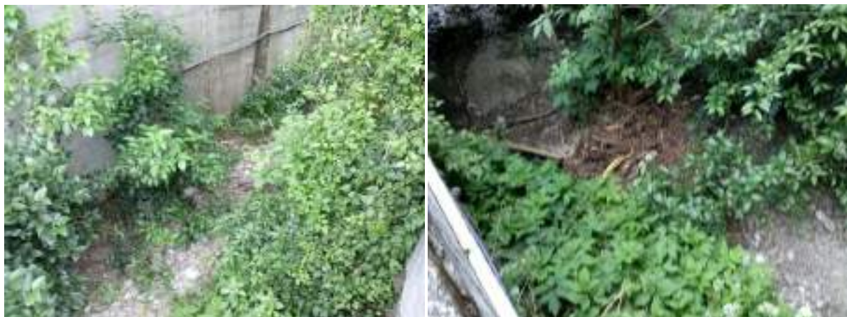
Foto 5.4 - Stazione T-GE-500 sul Rio Costiera (Maggio 2019), vista a monte a sinistra vista a valle a destra
