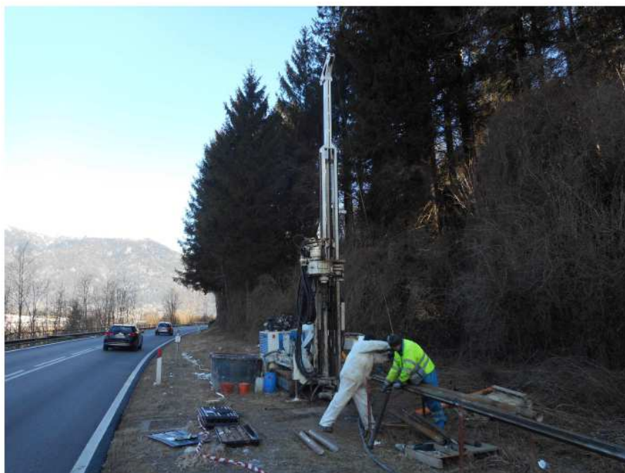
Sondaggio S1: posizionamento delle attrezzature.
