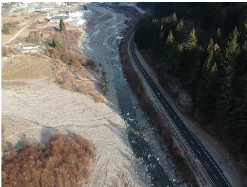
Panoramica da drone del tratto interessato dall'allargamento con soletta a sbalzo
