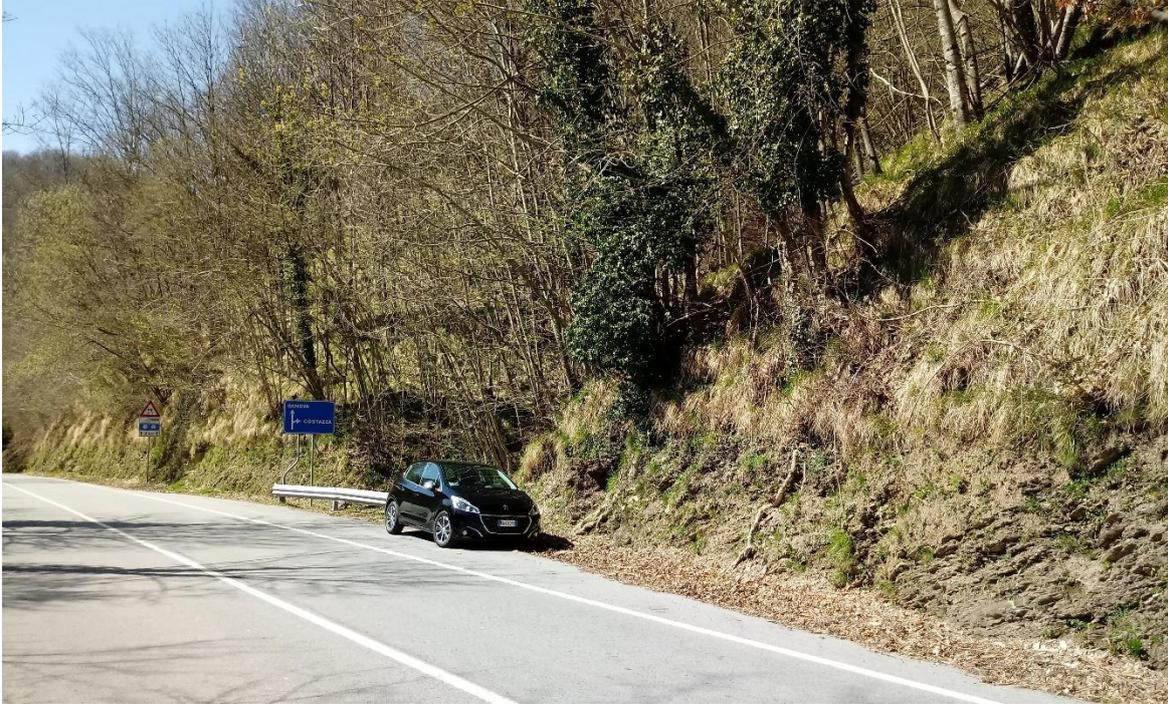
***Figura 40. Scavi di sbancamento realizzati durante la costruzione della S.S.45. Si noti la presenza continua di tali scarpate rocciose poste a monte dell'infrastruttura. Tratta compresa tra i punti di rilievo n°31, n°11 e n°10.***
