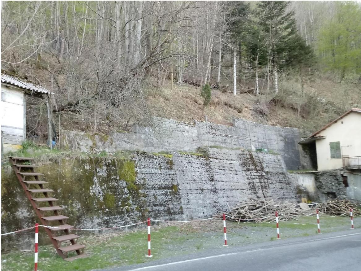
**Figura 37. Area soggetta ad erosione diffusa attiva. Settore di versante ubicato a monte del punto di rilievo n°38.**
