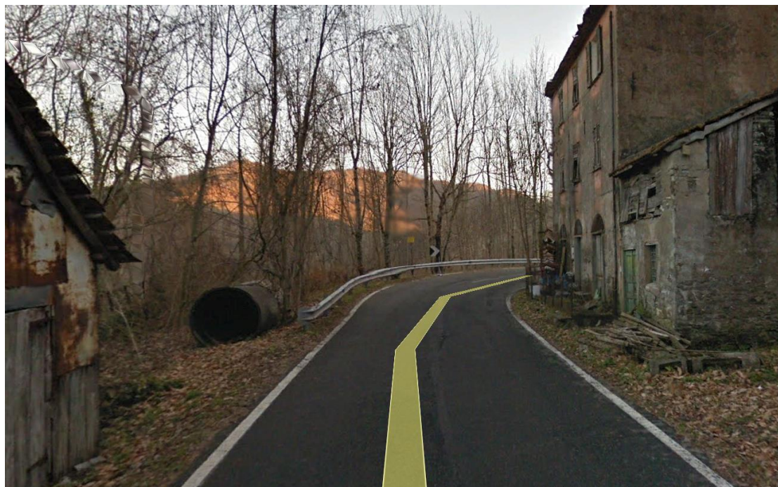
Fig. 5 – Presenza di accessi diretti
