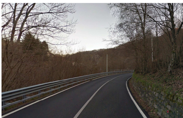
Figura 43: punto di vista 2 - stato di fatto
