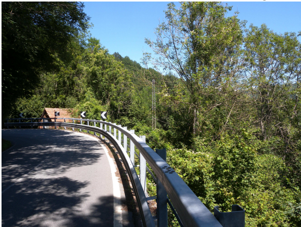
Figura 40: Viadotto Trebbia - Stato di fatto
