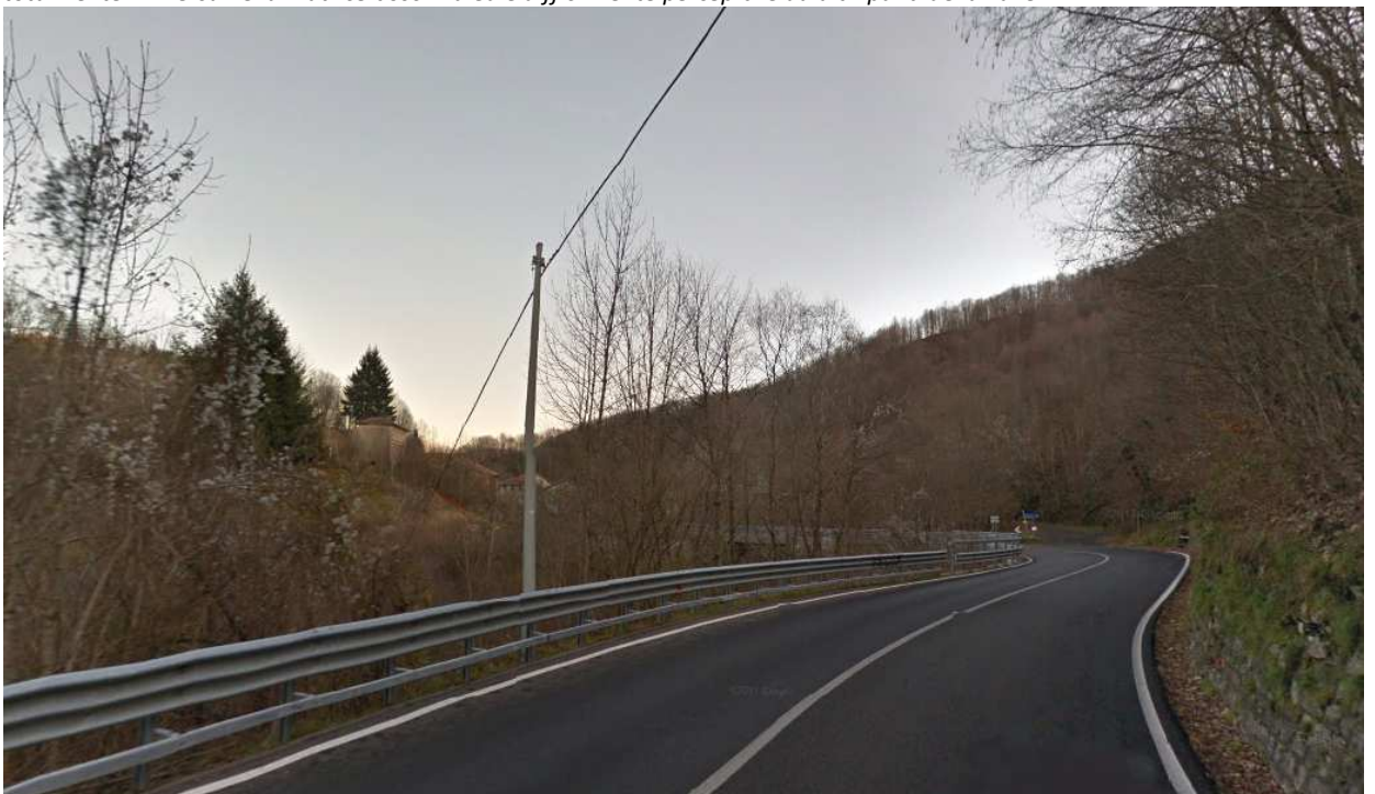
Figura 33: vista lungo la SS45 laddove verrà realizzato il viadotto alle porte dell'abitato di Ponte Trebbia
