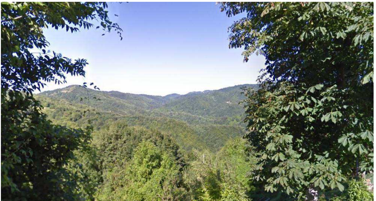
Figura 35: Vista sulla Val Trebbia da Cassinetta; in questo esempio il tracciato della SS 45 è perfettamente mimetizzato nel contesto.
