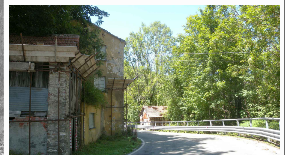
1. Edifici abbandonati lungo il tracciato di progetto della SS 45
