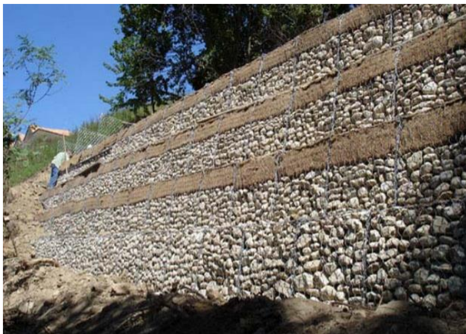
Fig. 17 - Esempio di muro in gabbioni
