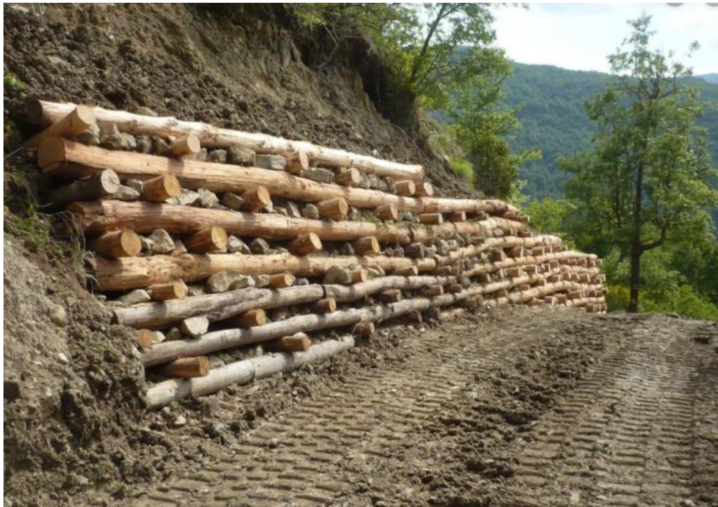
Fig. 16 - Esempio di muro cellulare in legno
