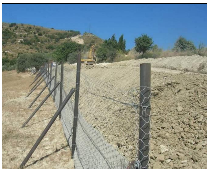
Fig. 10 - Esempi di opere temporanee per il contenimento del terreno
