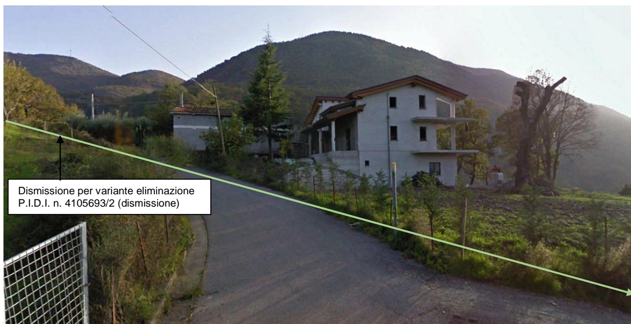
Fig. 57 - Attraversamento in corrispondenza della strada vicinale del Malfitano
