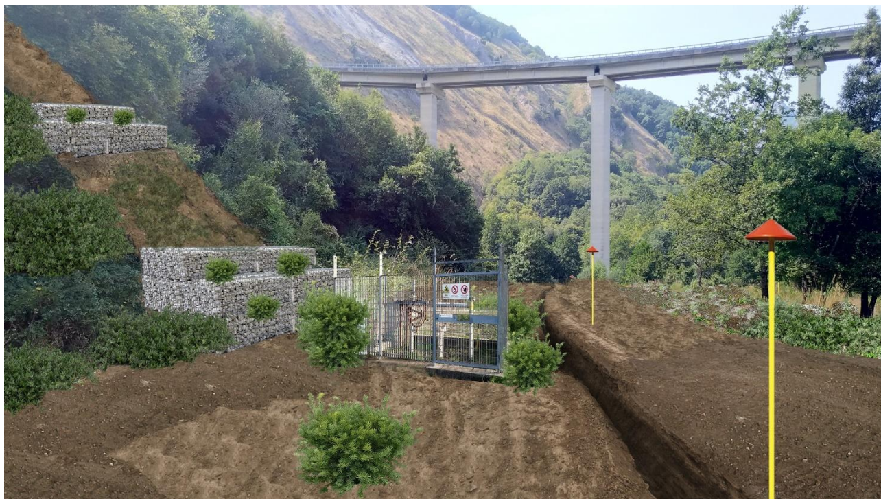
Fig. 44 – Impianto P.I.D.I. e realizzazione gabbionate
