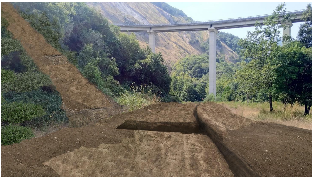
Fig. 43 – Fase di scavo e pulizia scarpata
