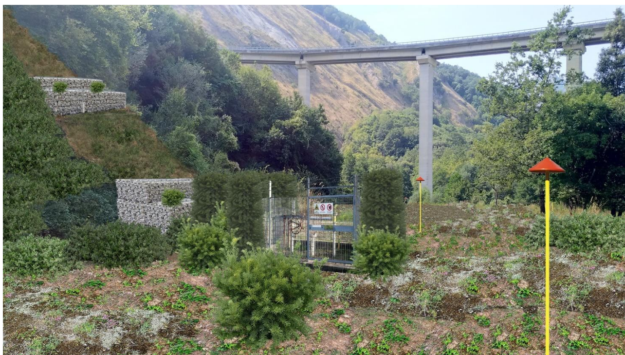
Fig. 45 – Ripristino scavo e mascheramento
