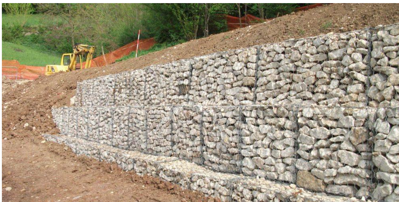
Fig. 35 – Esempio di Ripristino Morfologico – Muro in Gabbioni Impianto PIDI
