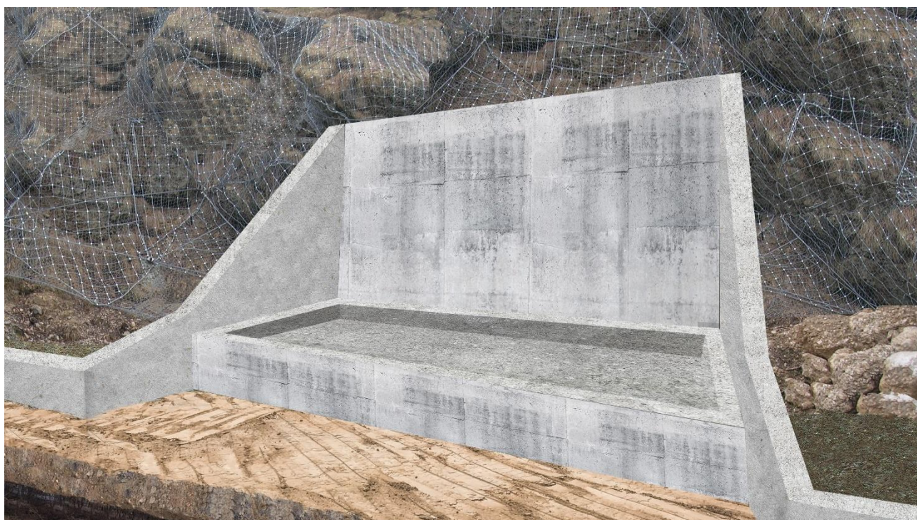
Fig. 39 – Realizzazione muro di contenimento e fondazioni P.I.L.
