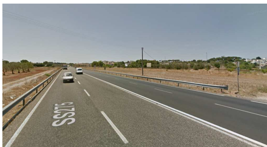
Fig. 5. SS.275 Km 3 – Doppia corsia per senso di marcia, assenza di spartitraffico
