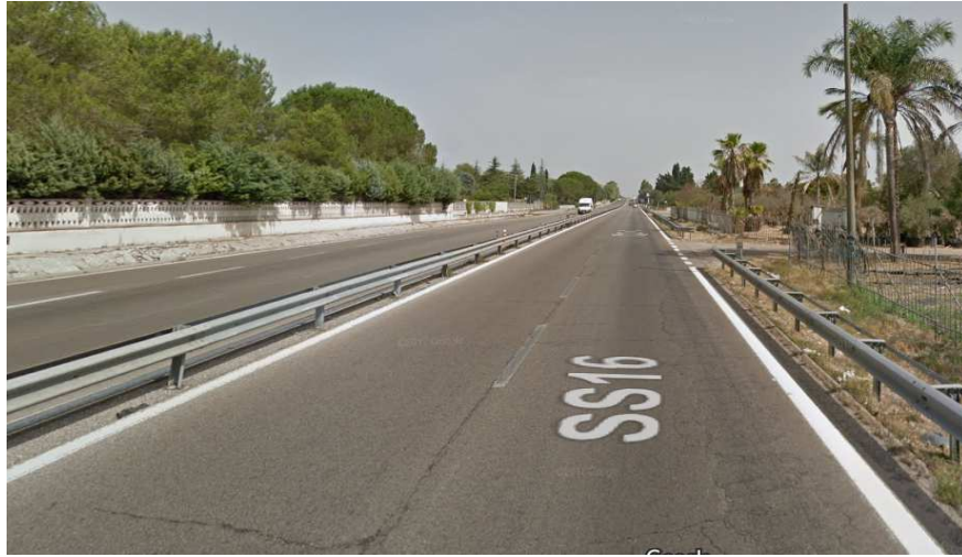
Fig. 1. SS.16 Km 984 – Presenza di spartitraffico
