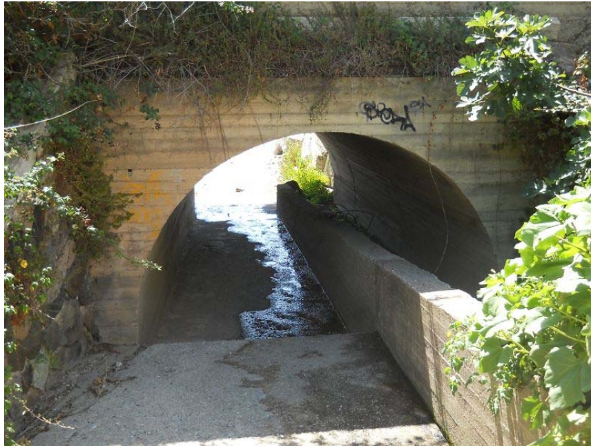
Attraversamento esistente: vista ingresso lato monte
