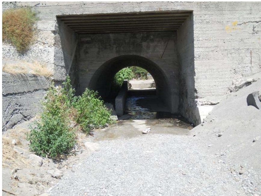
Attraversamento esistente: vista sbocco lato mare
