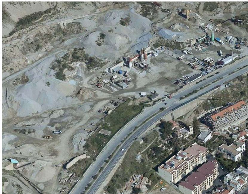
Vista aerea dell'area di cantiere
