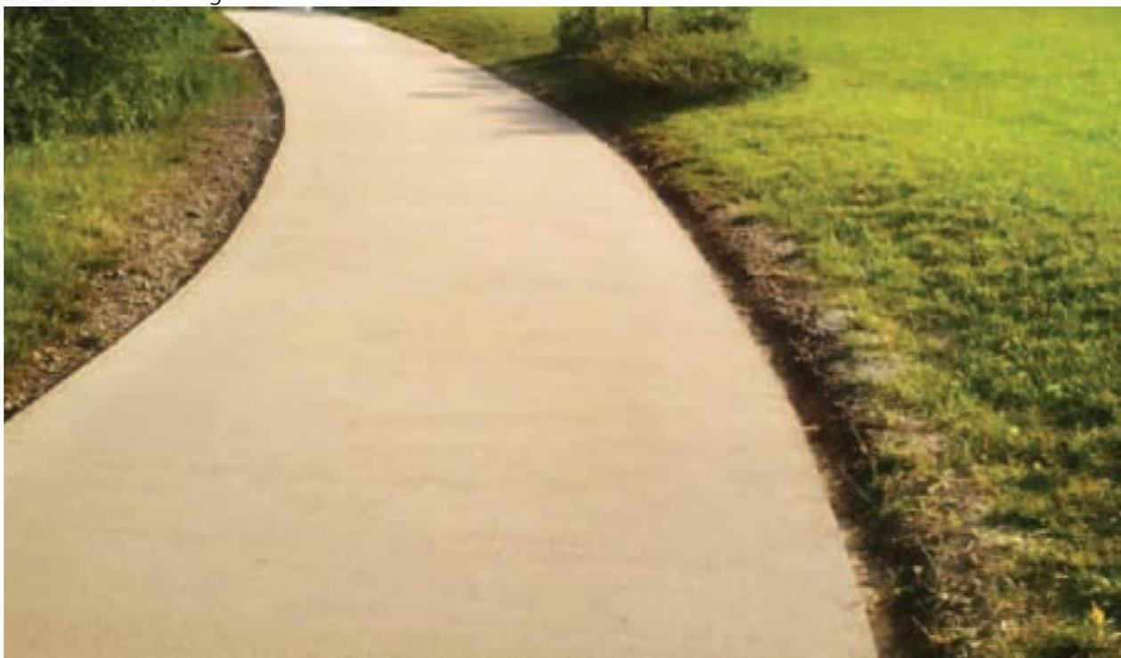
Il conglomerato ecologico, costituito da inerti a granulometria selezionata, leganti idraulici e speciali additivi, consente di realizzare pavimentazioni carrabili completamente esenti da idrocarburi e derivati del petrolio (catrame e di conseguenza asfalto), con un aspetto finale che conserva le caratteristiche di materiali e di colore tipici del luogo dove viene eseguito il lavoro, garantendo un risultato con un basso impatto ambientale.
