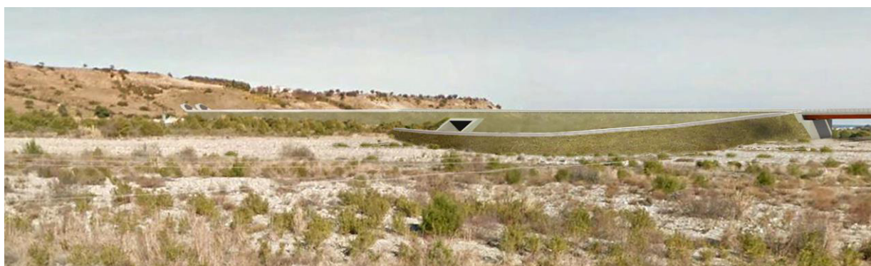
Fig. 18 Svincolo Roseto sud post-operam
