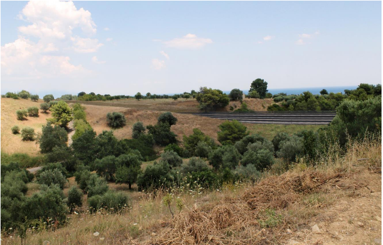
Fig. 16 Il tratto allo scoperto di approccio alla Galleria Taviano
