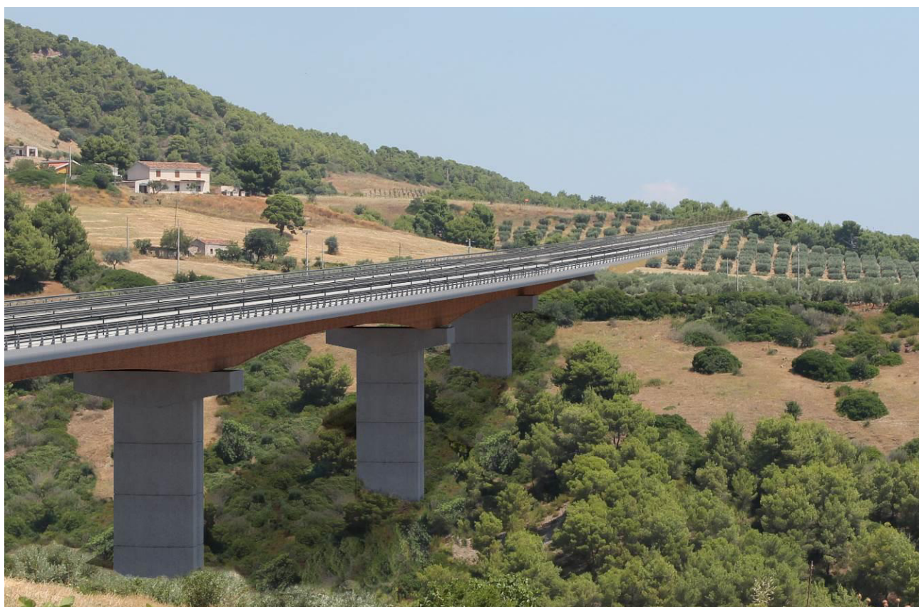
Fig. 6 Imbocchi sud Galleria Schiavi dall'area del viadotto Forno
