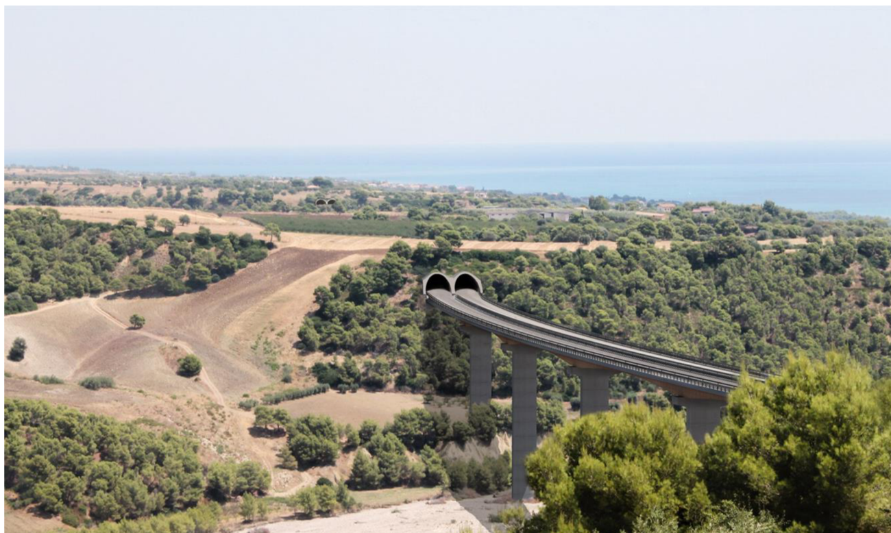
Fig. 8 Imbocchi sud Galleria Stellitano
