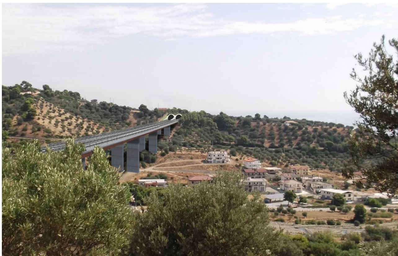
Fig. 2 Gli imbocchi sud della galleria Pagliaro
