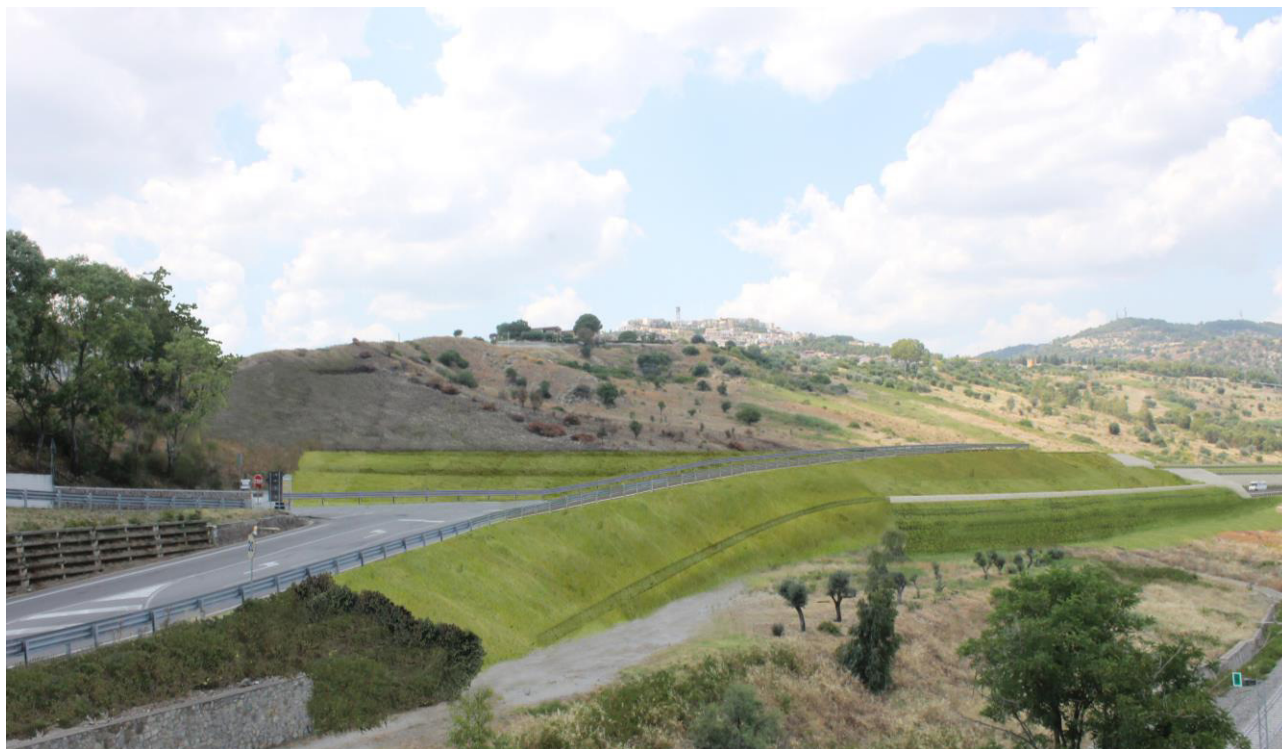
Fig. 23 Vista dal Castello Federiciano di Roseto Capo Spulico, post-operam
