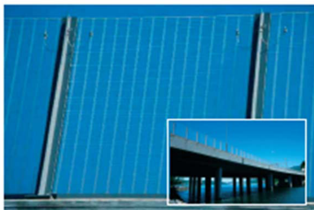
Esempio di trattamento di superfici trasparenti atto ad evitare le collisioni con l'avifauna (da COST 341)
