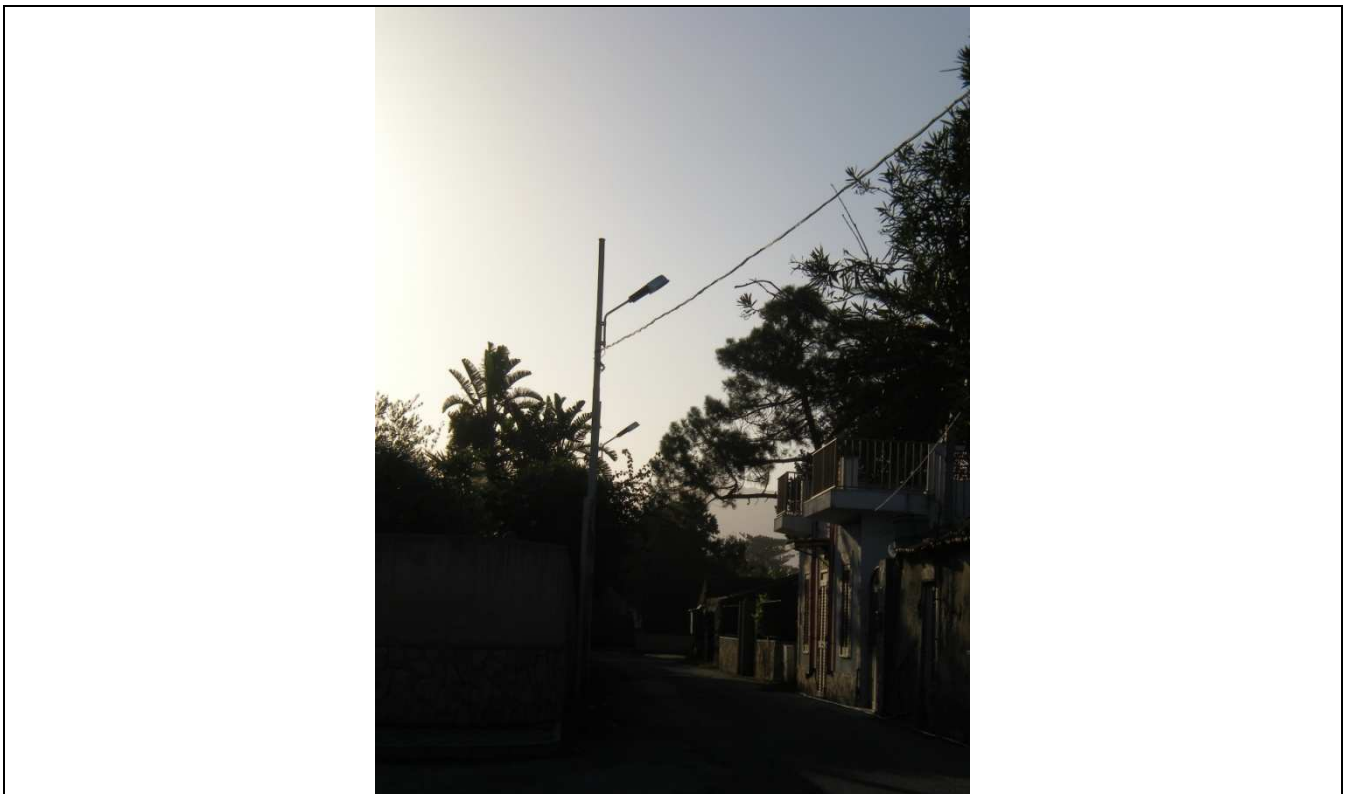
Via Margi, in complesso due torri (viabilità interna)
