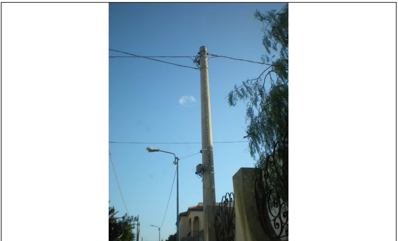
Via Margi, in complesso due torri (viabilità interna)
