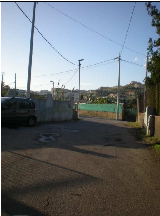
Via Margi, in complesso due torri (viabilità interna)
