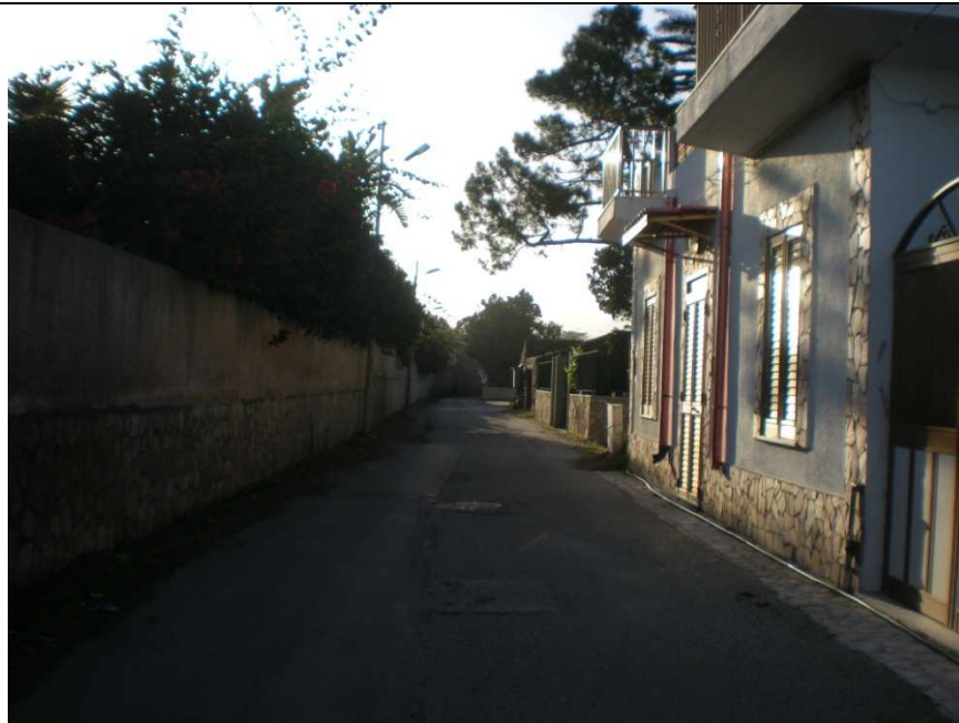
Via Margi, in complesso due torri (viabilità interna)
