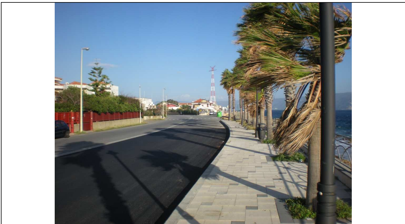
Via Circuito in località Ganzirri
