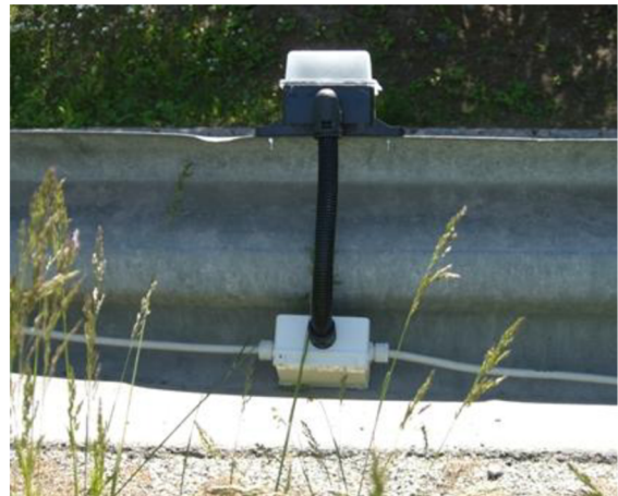
Figura 8 Contenitore morsettiera per collegamenti elettrici GRAPE/WEDGc (versione cablata)
