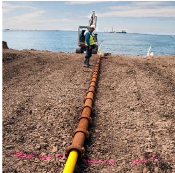
Figura 3.8 – Sistema “a gusci” per la protezione dei cavi
