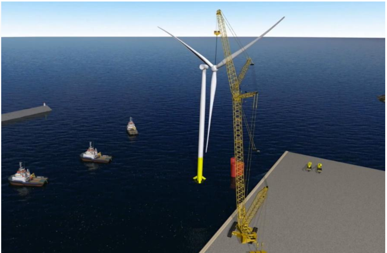
Figura 4.2 – Operazione di sollevamento del rotore completo della turbina eolica (Fonte: SOT A/S)
