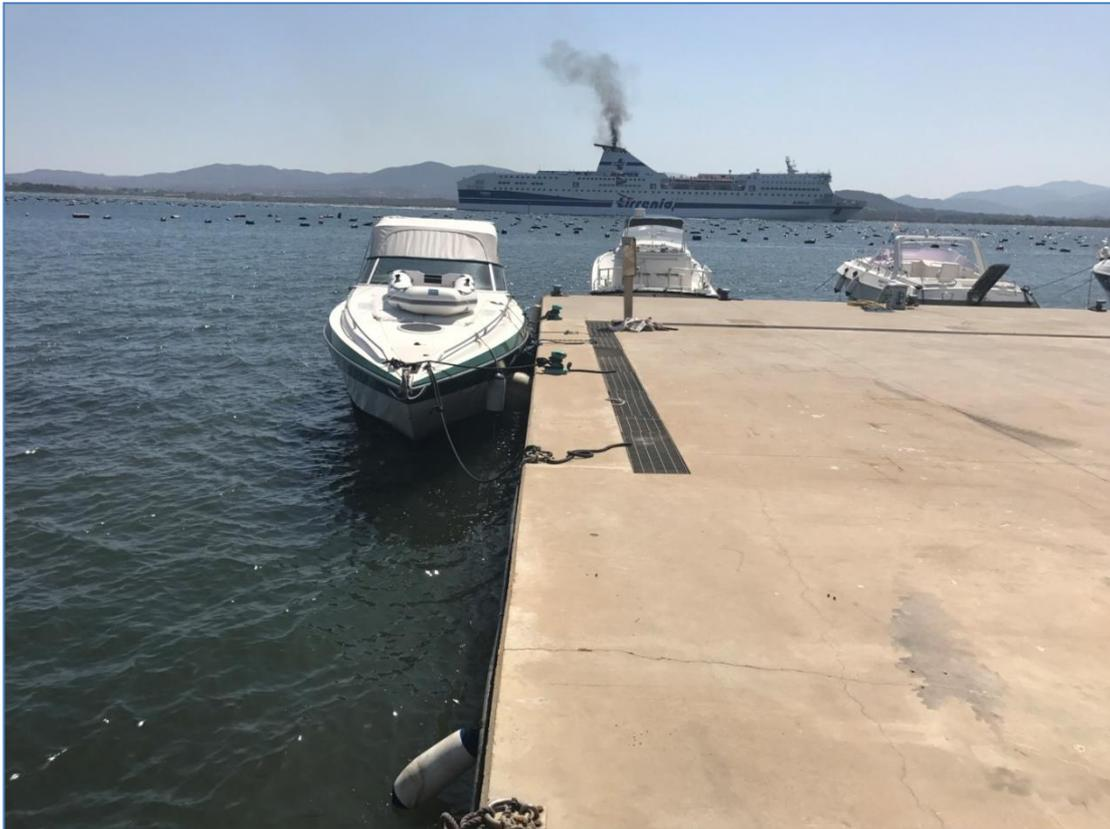
**Figura 9 Canaletta esistente per la raccolta acque di prima pioggia**
