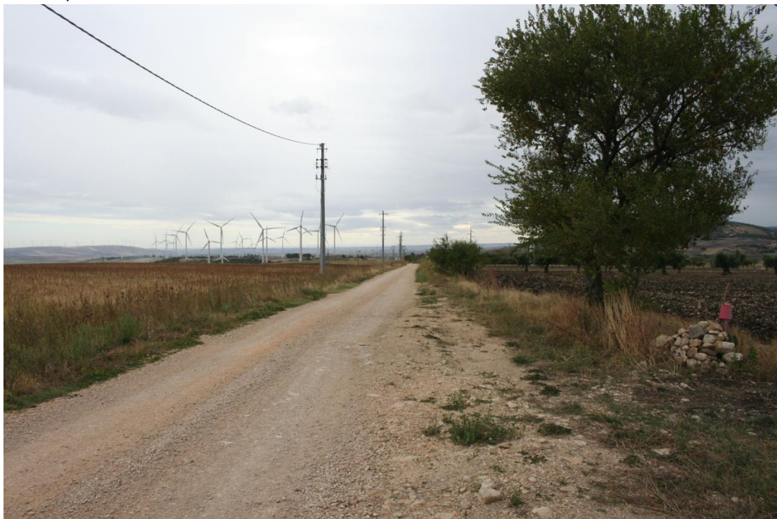
6 - Troia (FG), loc. Vigna Cancarro: cavidotto di interconnessione dalla T 12 alle T3 e T5 corrente lungo tratturo Titolone, panoramica direzione SE
