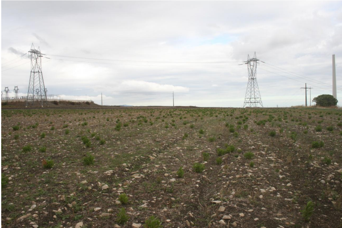
3- Troia (FG), loc. Monsignore: area della stazione di consegna alla RTN, panoramica in direzione N
