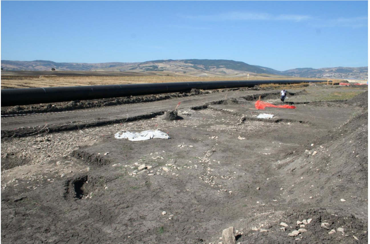
Lo scavo in corso nel 2011 in corrispondenza dell'AR 3 in occasione della messa in posa del metanodotto
