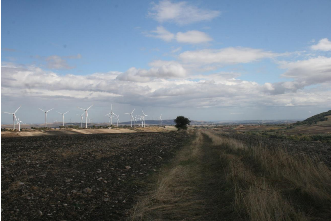
23 - Troia (FG), loc. Montebifero: panoramica del cavidotto di interconnessione alle T 16
