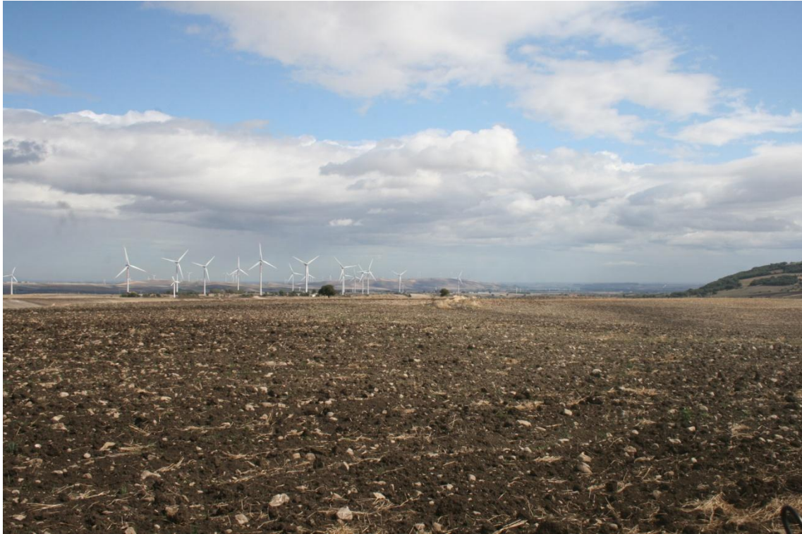
21 - Troia (FG), loc. Montebifero panoramica del cavidotto di interconnessione alle T 9 e T16, corrente su strada interpoderale
