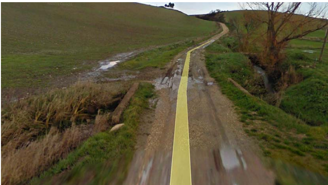
Opera di attraversamento esistente sul fosso Cancarro
