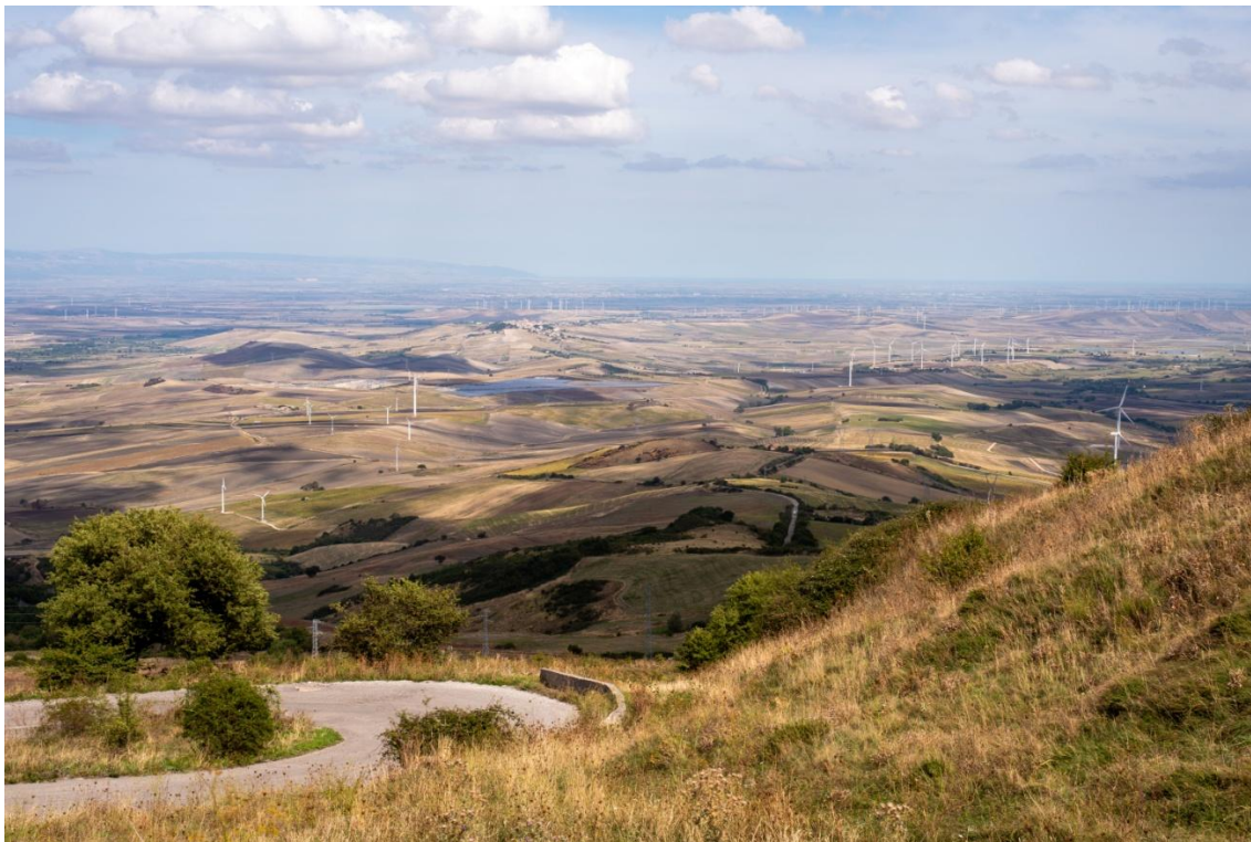
Figura 25 - Vista del paesaggio attuale in prossimità dell'area di inserimento (loc. Str. Ignazia)
