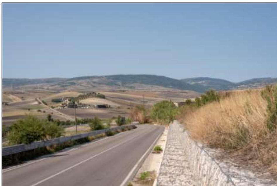
**Figura 13 – Elementi di contenimento in gabbioni lungo la SP 123**
