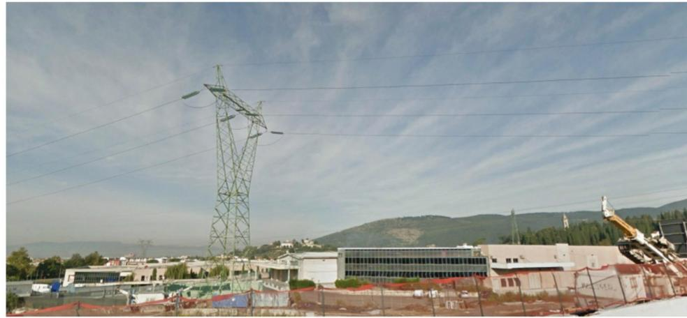
1 - Stato di Fatto - Vista verso ovest dall'autostrada A1. In primo piano il sostegno della linea a 220 kV "Casellina - S. Benedetto del Querceto" da demolire.
