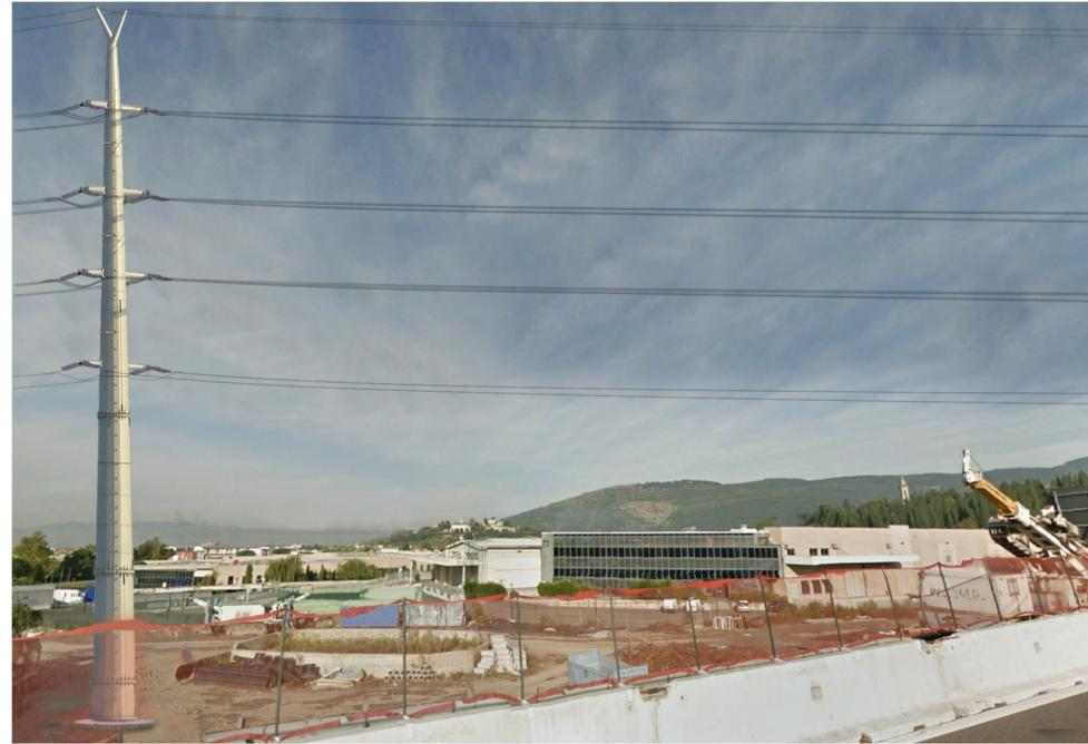
1 - Stato di Progetto - Fotoinserimento del sostegno n. 222 della nuova linea 380 kV, con inserimento di loop passivo.
