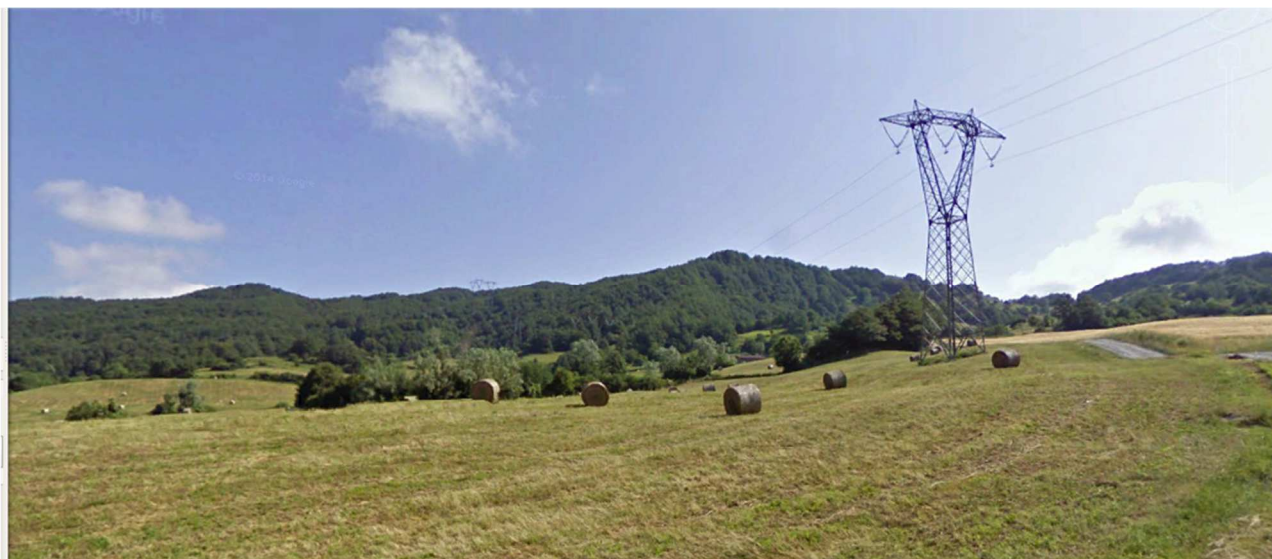
Figura 50: Vista dei sostegni esistenti di cui è previsto il riutilizzo (131 in lontananza e 132 in primo piano)
