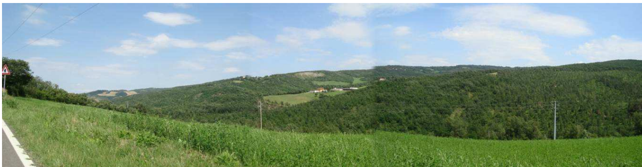
Figura 47: Tratto in corrispondenza dei sostegni 85 – 86
