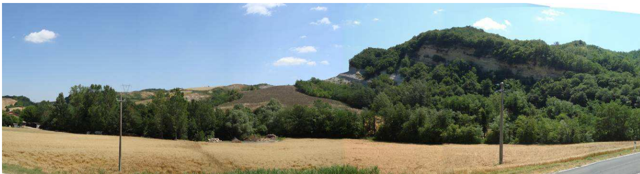
Figura 41: Vista dal fondovalle dello Zena: sulla sinistra i versanti interessati dalla campata 42-43
