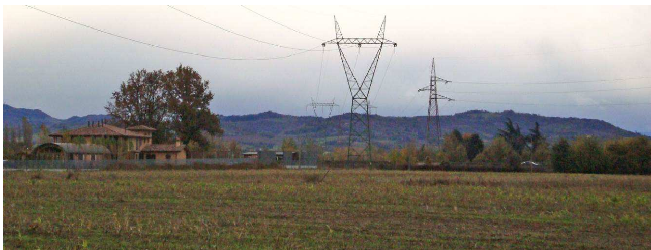
Figura 32: vista della pianura agricola ai piedi delle colline dove è visibile anche l'esistente linea che verrà demolita (sulla sinistra)
