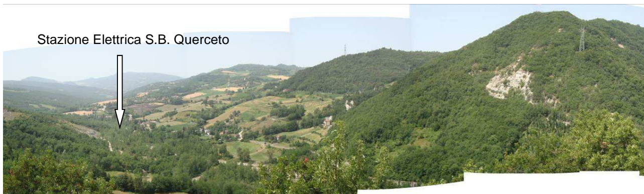
Figura 44: vista dalla chiesa di Sant'Alessandro verso le aree in esame
