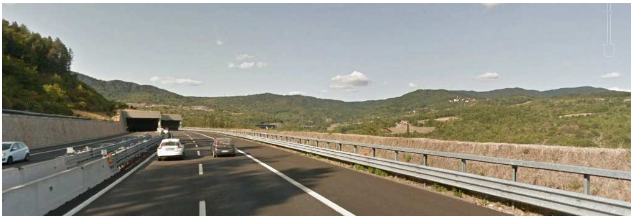
Figura 52: Vista dalla variante di valico verso la campata tra sostegni 155-156 di attraversamento (in corrispondenza della galleria artificiale)
