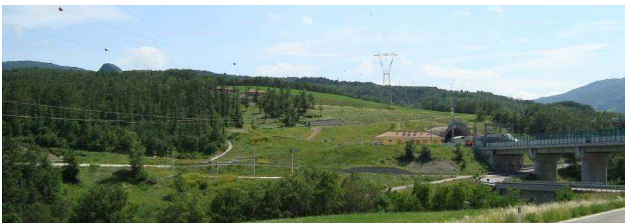
Figura 48: Tratto in corrispondenza dei sostegni 87 - 88. In primo piano la linea da smantellare
