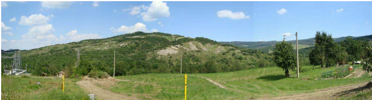
Figura 46: Tratto in uscita dalla stazione di S. Benedetto del Querceto
