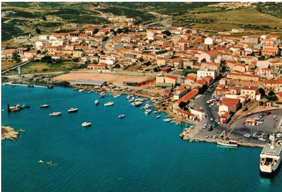
Foto 9: Sono appena iniziati i lavori per il porto turistico. Il traghetto ormeggia "di punta"
