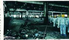
Lo stato di degrado in cui versa l'area ex-Necchi
