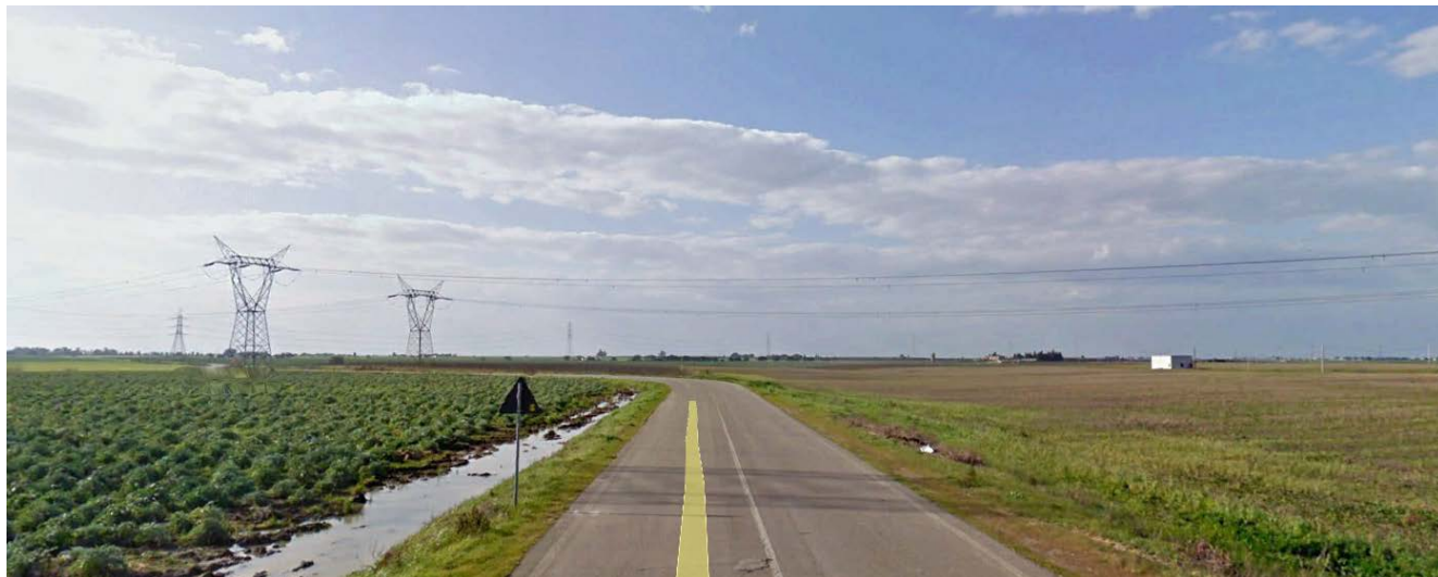
Figura 5-3: SP 81 verso l'impianto
