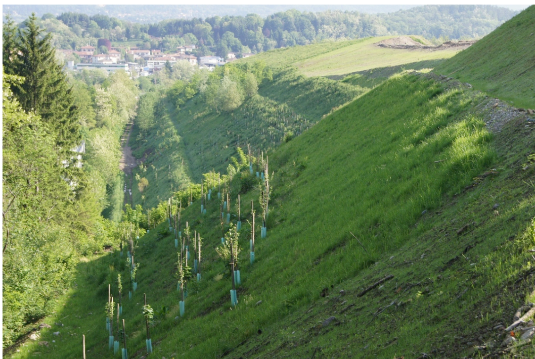
Fig. 40 scarpata occidentale T1+2 - con piantagioni in esecuzione, stato 2013 (foto: Dionea SA)
