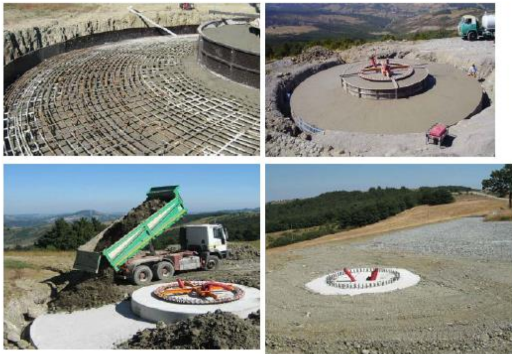
Particolare esecuzione plinti di fondazione
