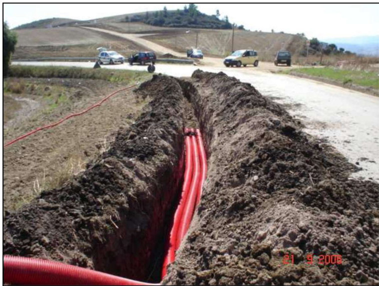
Foto illustrativa della messa in posa dei cavidotti MT
