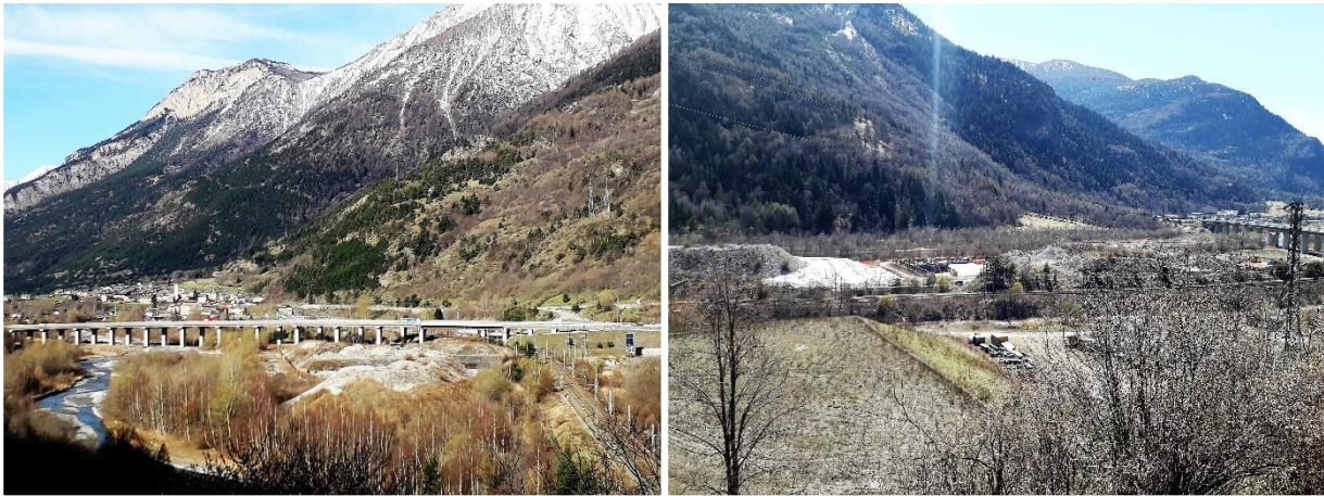
Figura 4. Area di studio che comprende la zona prevista per il Cantiere industriale e la zona limitrofa (zona ripariale, versante destro e sinistro orografico) nel Comune di Salbertrand in Alta Valle Susa.
