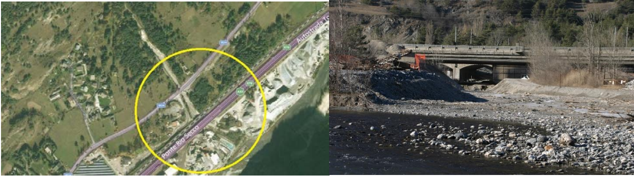
Figura 7. Sottopassi poco a valle della frazione San Romano (a sinistra) e ponti sotto autostrada e ferrovia (a destra).
