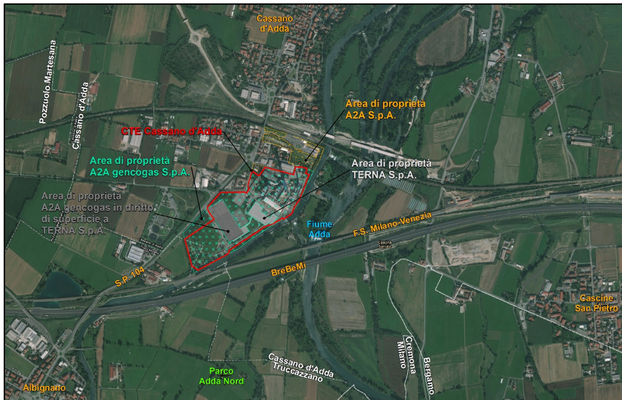
Figura 3.1a Localizzazione della Centrale Termoelettrica A2A gencogas di Cassano d'Adda
