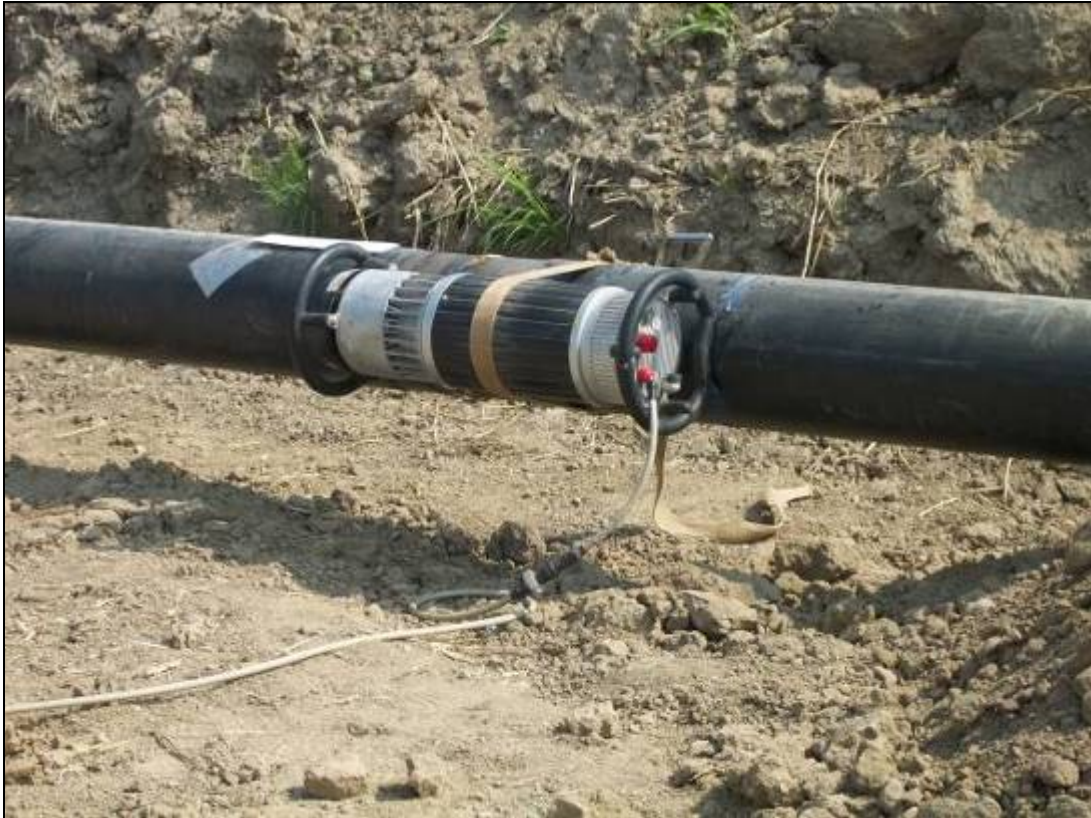
Fig. 3.1.6- Controlli non distruttivi delle saldature
