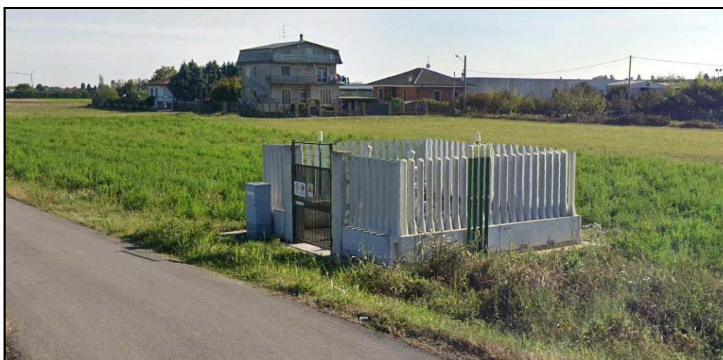
Fig. 3.1.12/B: Installazione tipo impianto di linea con recinzione in pannelli in cls prefabbricati
