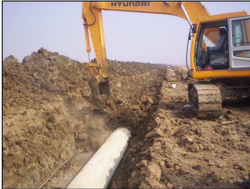
Fig. 3.1.10 - Rinterro della condotta
