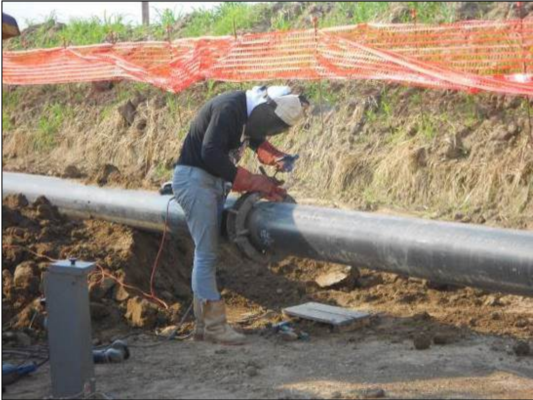
Fig. 3.1.5 Saldatura della tubazione
