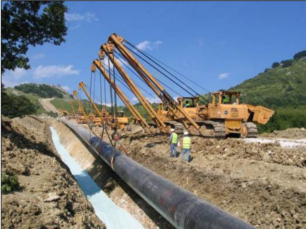
Fig. 3.1.9 - Posa della condotta
