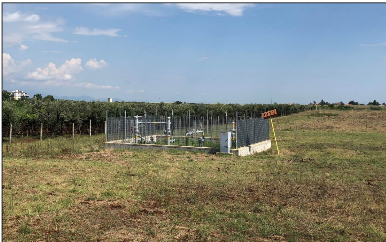
Fig. 5/C: Installazione tipo impianto di linea con pannelli in grigliato di ferro verniciato
