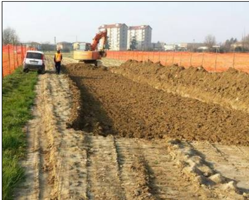
Fig. 3.1.2: Apertura della pista di lavoro
