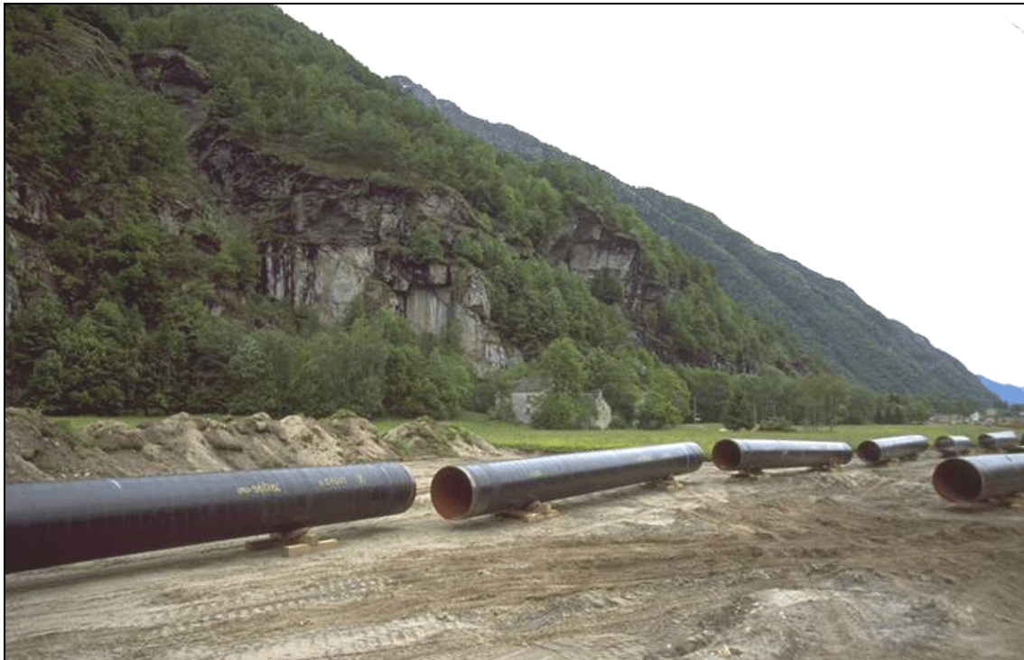
Fig. 3.1.4 - Sfilamento tubi
