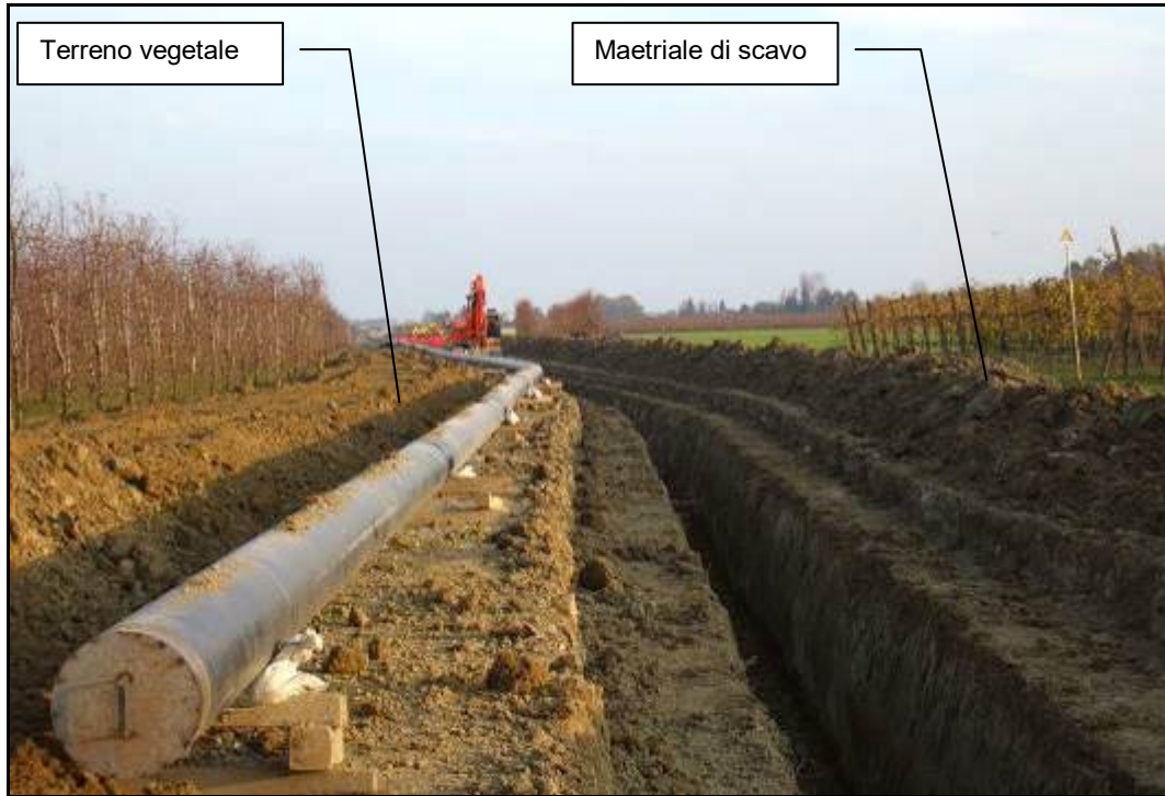
Fig. 3.1.7 - Scavo della trincea
