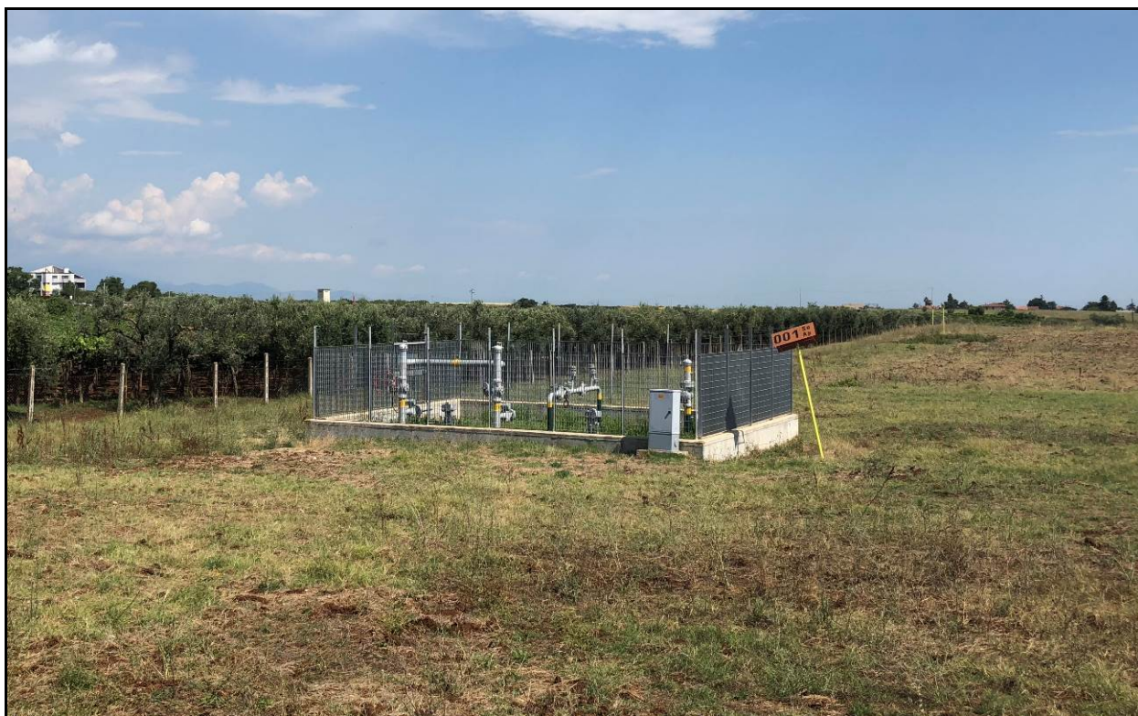
Fig. 9/C: Installazione tipo impianto di linea con pannelli in grigliato di ferro verniciato
