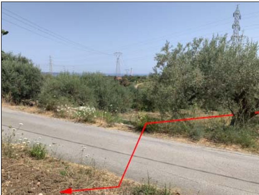
Foto 2/F – Vista contro senso gas dell'attraversamento strada comunale in Contrada Sant'Agata
