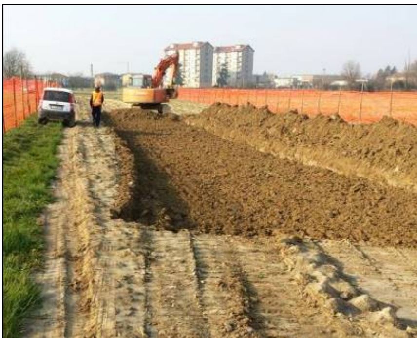
Fig. 5.1.2: Apertura della pista di lavoro
