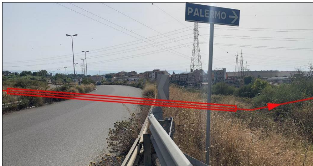
Foto 2/T – Vista dell' attraversamento dell'asse viario Zona Industriale in trivellazione
