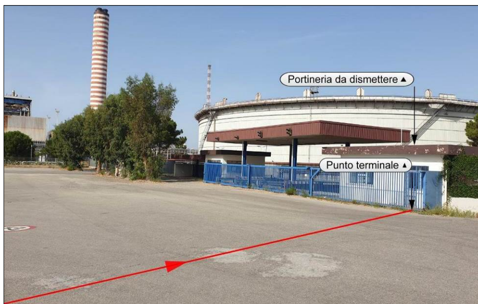
Foto 2/V – Vista piazzale della raffineria di San Filippo del Mela con ubicazione area impianto PIDA/C km 4+998
