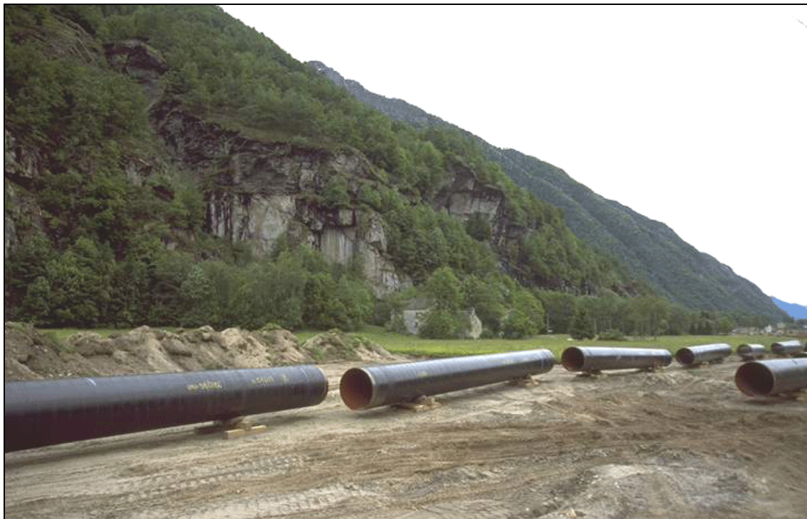
Fig. 5.1.4 - Sfilamento tubi
