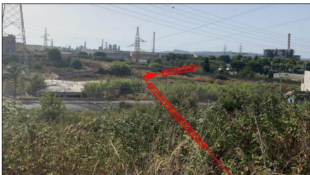
Foto 2/U – Panoramica senso gas degli attraversamenti della S.S. N.113 e della Ferrovia Messina-Palermo in trivellazione
