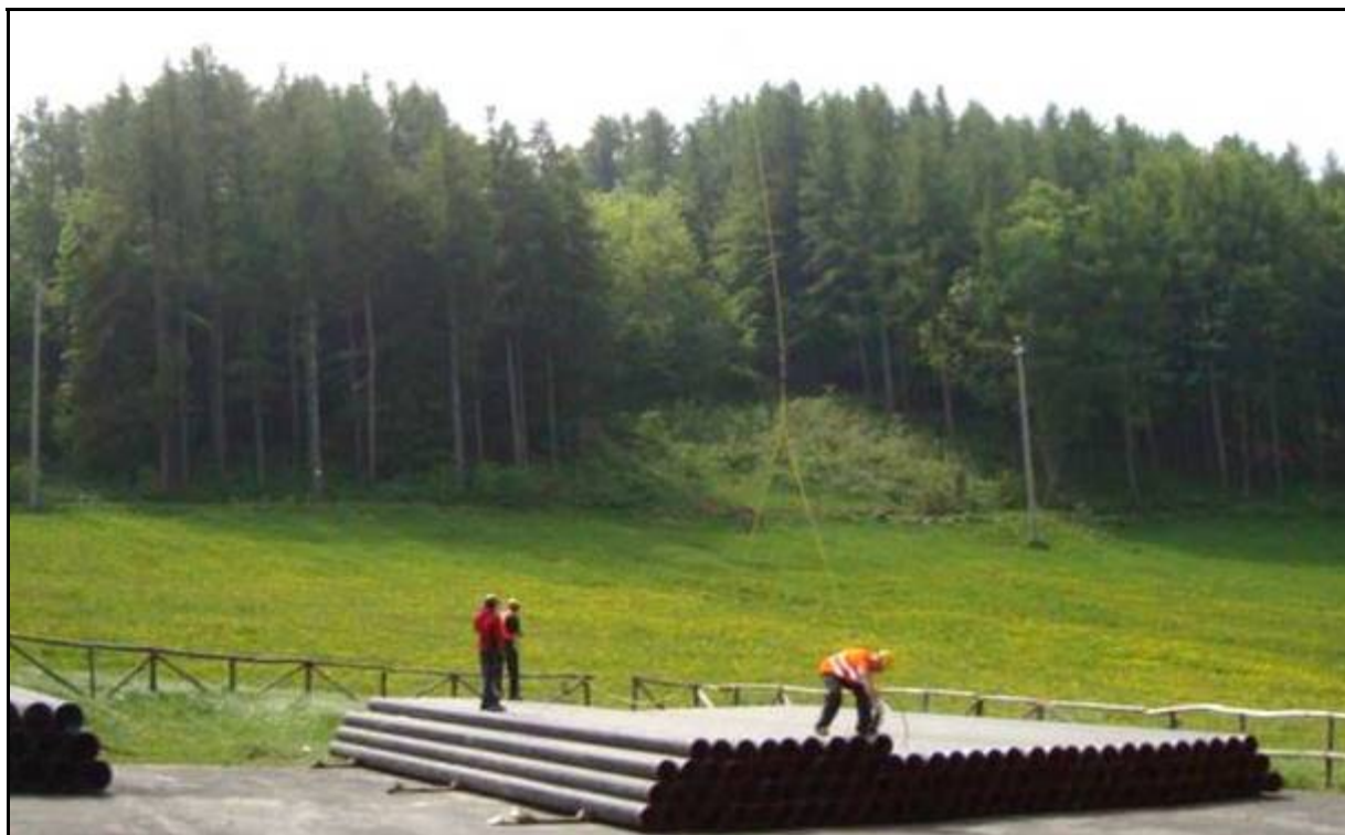
Fig. 5.1.1: Piazzola di accatastamento tubazioni
