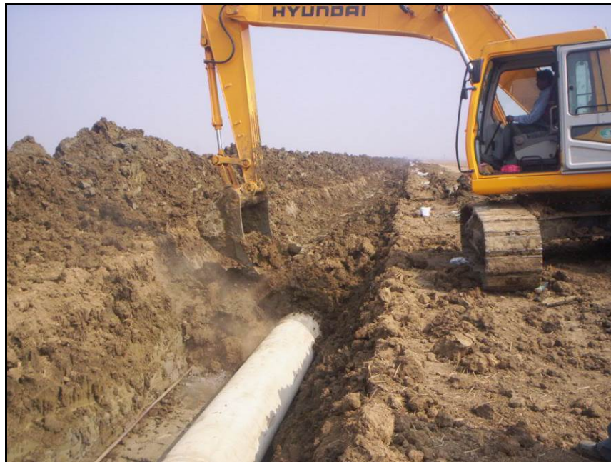
Fig. 5.1.10 - Rinterro della condotta
