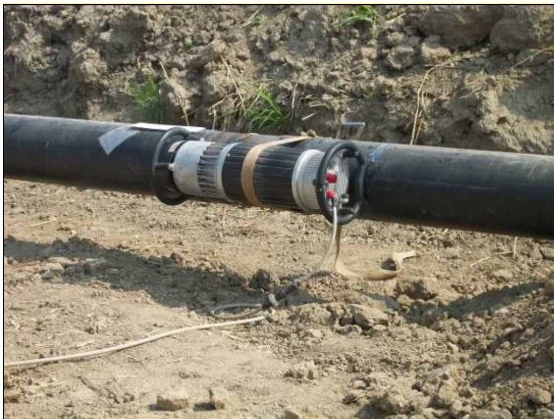
Fig. 5.1.6- Controlli non distruttivi delle saldature
