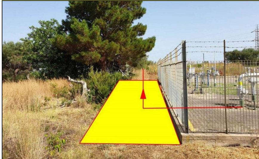
Foto 2/B – Impianto N. 6101001/10A sul Met. G.A.M.E.A DN 1200 (48") da ampliare
