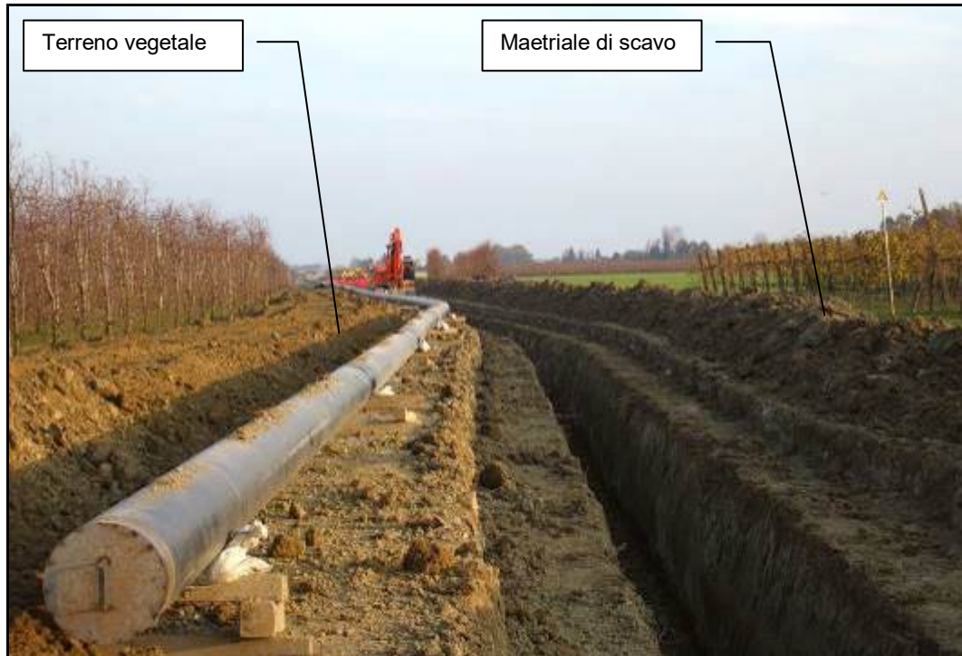
Fig. 5.1.7 - Scavo della trincea
