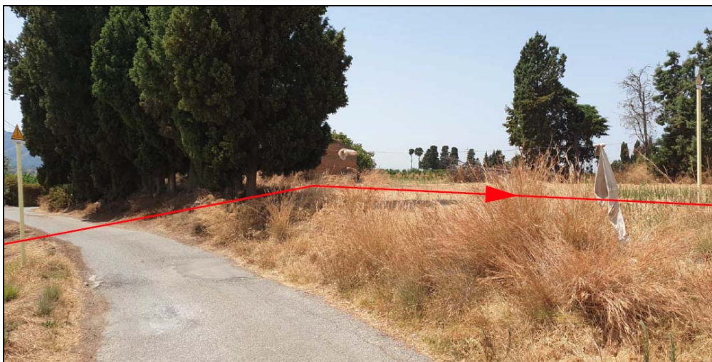
Foto 2/I – Vista attraversamento strada comunale in Contrada Peillo a cielo aperto
