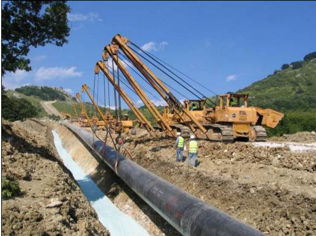
Fig. 5.1.9 - Posa della condotta
