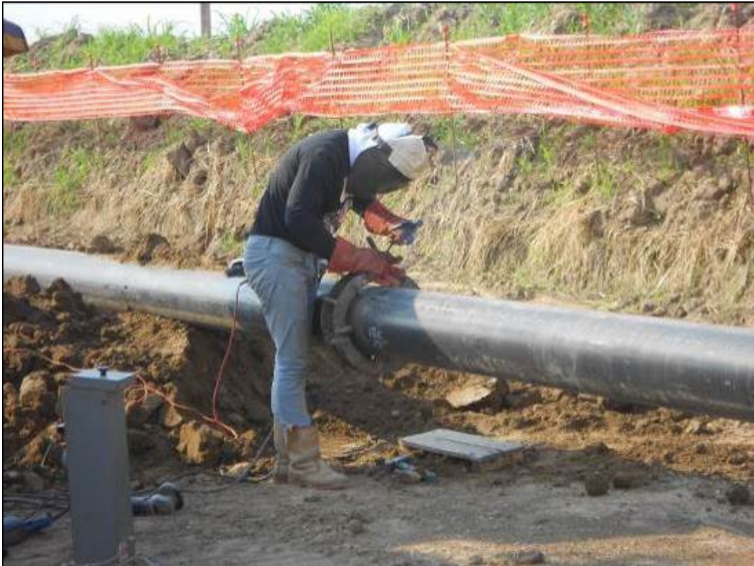
Fig. 5.1.5 Saldatura della tubazione
