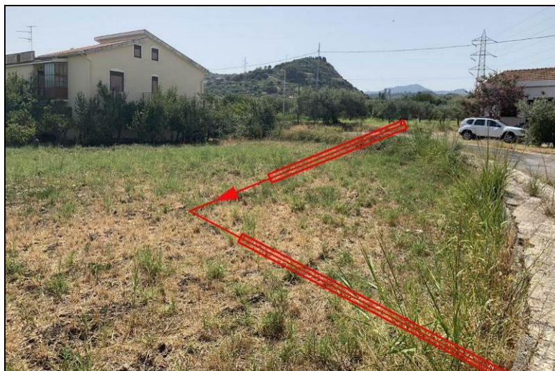
Foto 6/C – Vista contro senso gas dell'attraversamento della strada della Frazione G. Verga in trivellazione e ingresso trivellazione area di urbanizzazione
