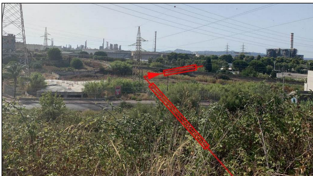
Foto 6/U – Panoramica senso gas degli attraversamenti della S.S. N.113 e della Ferrovia Messina-Palermo in trivellazione
