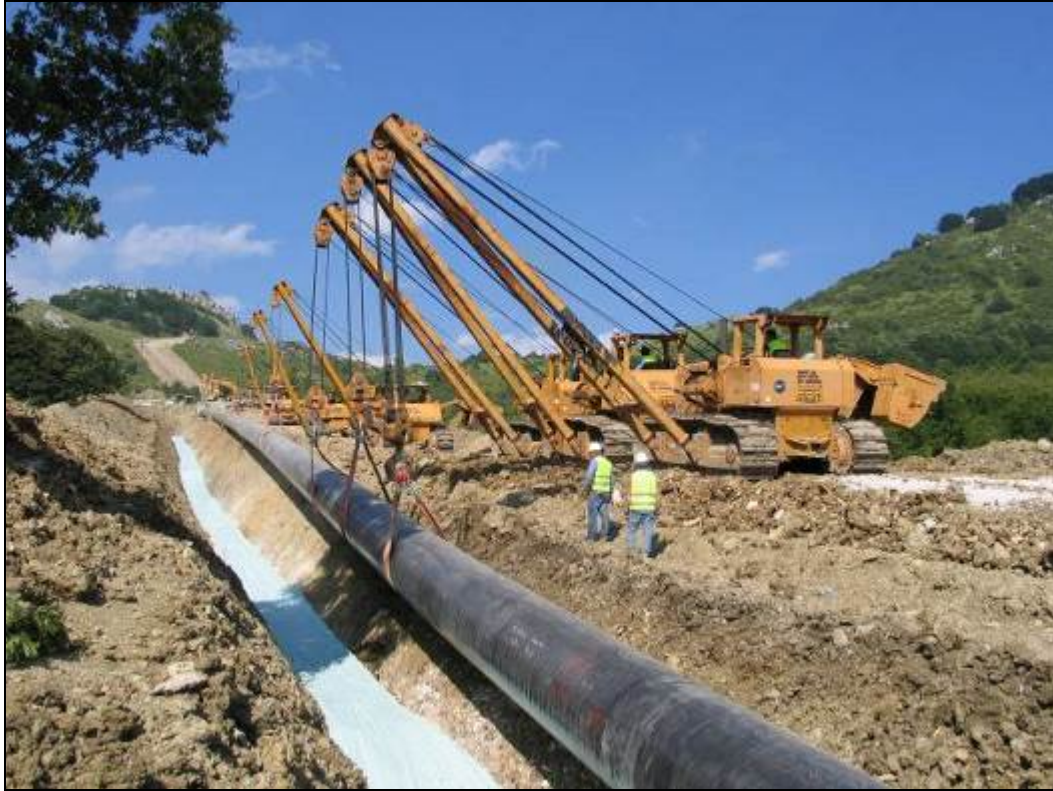
Figura 9.1.9 – Posa della condotta
