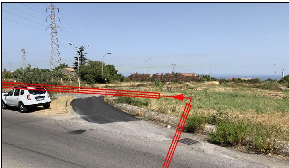
Foto 6/D – Vista senso gas dell'attraversamento della strada della Frazione G. Verga in trivellazione e trivellazione area di urbanizzazione
