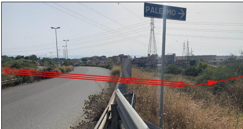
Foto 6/T – Vista dell' attraversamento dell'asse viario Zona Industriale in trivellazione
