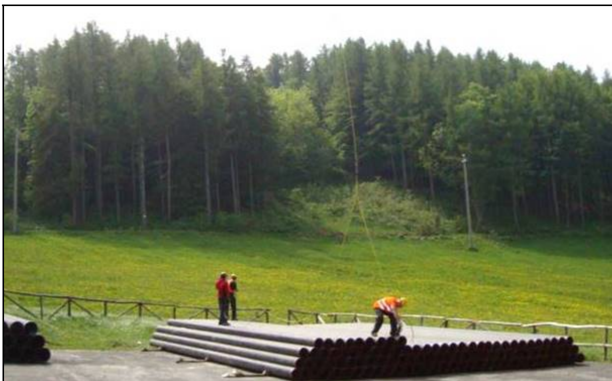
Fig. 9.1.1 - Piazzola di accatastamento tubazioni
