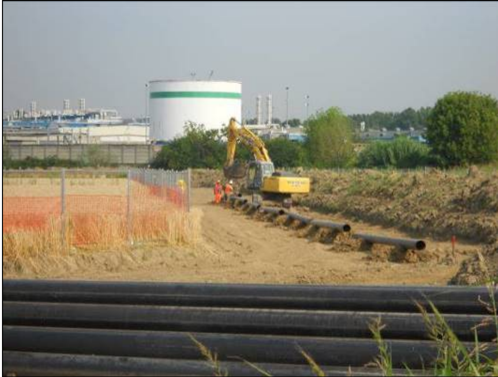
Figura 9.1.4: Sfilamento tubi
