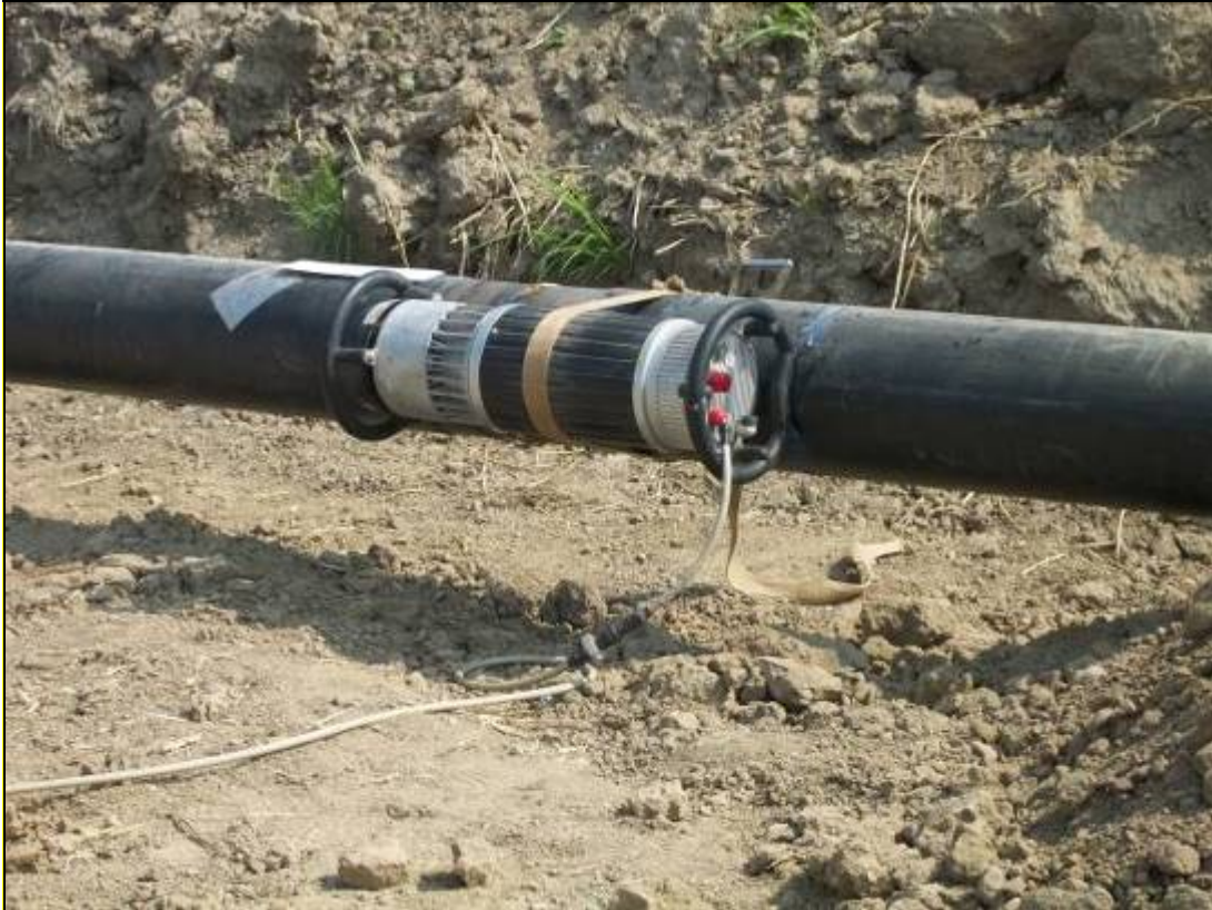
Fig. 9.1.6: Controlli non distruttivi delle saldature
