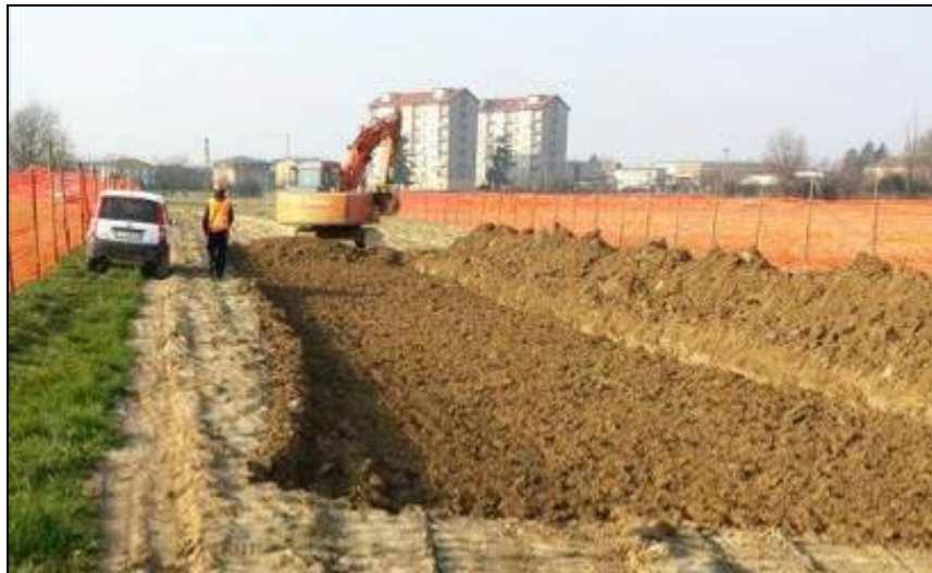
Fig. 9.1.2 - Apertura della pista di lavoro
