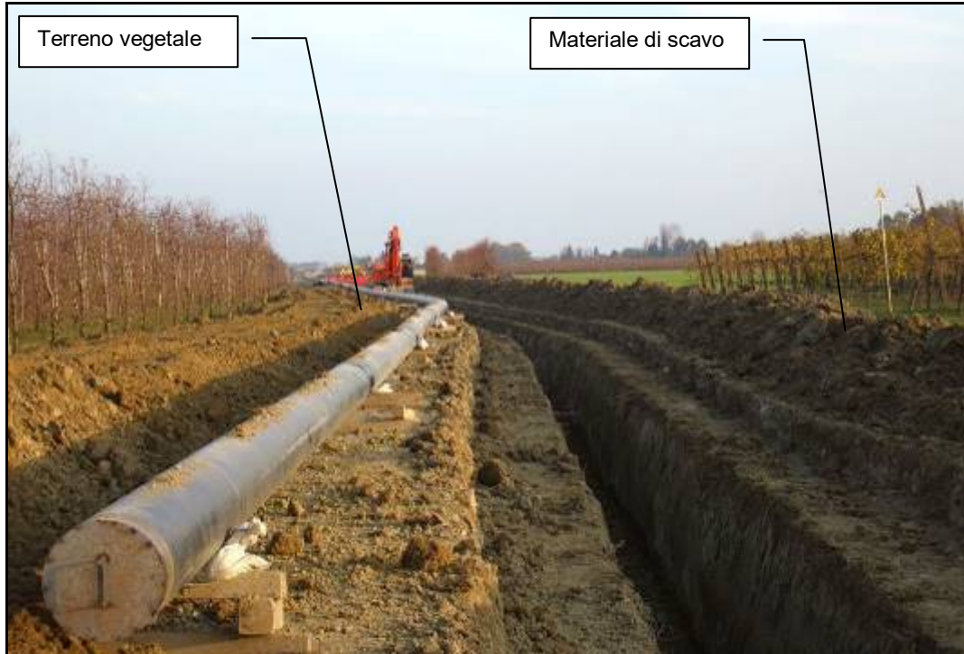
Figura 9.1.7 - Scavo della trincea
