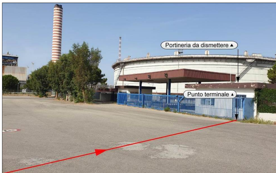
Foto 6/V – Vista piazzale della raffineria di San Filippo del Mela con ubicazione area impianto PIDA/C km 4+998
