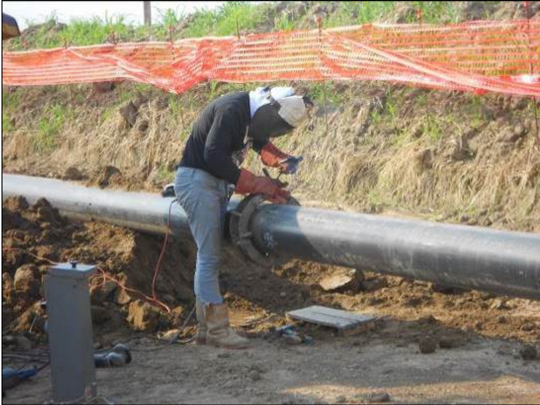
Fig. 9.1.5: Saldatura della tubazione
