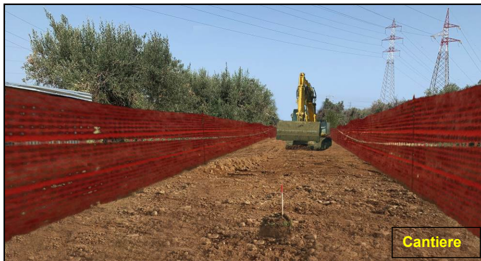
Foto 4/C-2 – Ripristini in aree a colture arboree (fase di cantiere)
