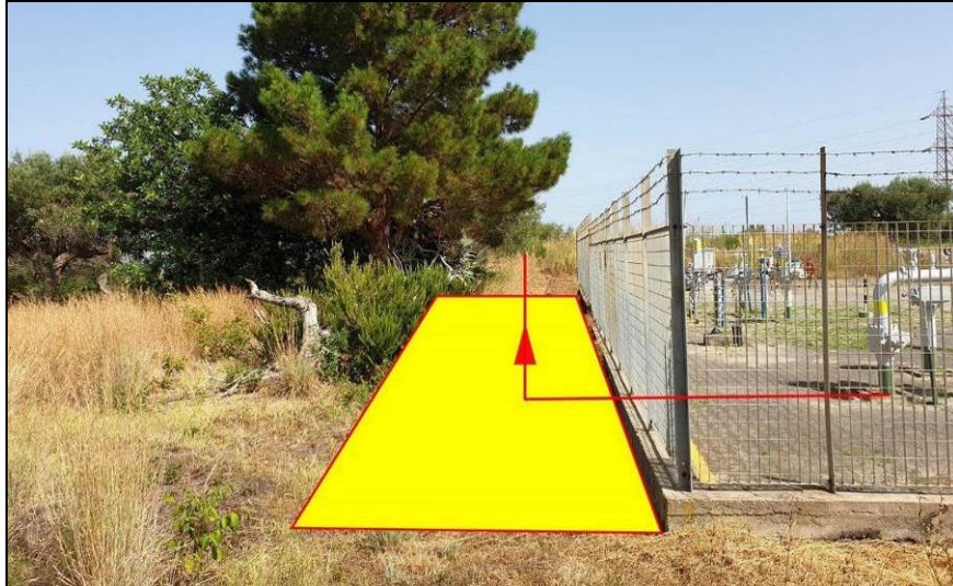
Foto 6/B – Impianto N. 6101001/10A sul Met. GA.ME.A DN 1200 (48") da ampliare
