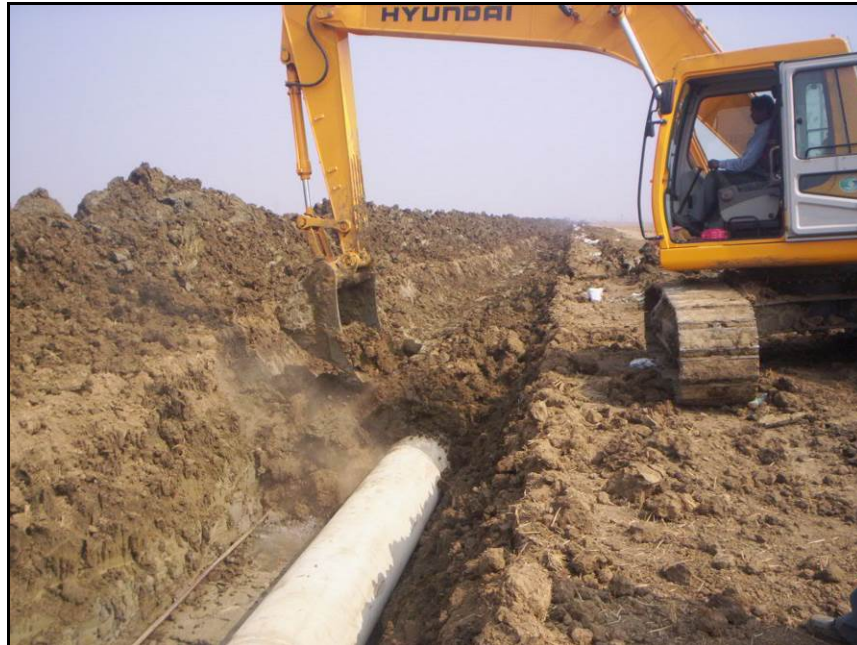
Figura 9.1.10 - Rinterro della condotta
