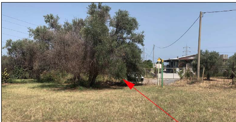
Foto 6/G – Vista senso gas dell'attraversamento strada comunale in prossimità Frantoio Mastroeni
