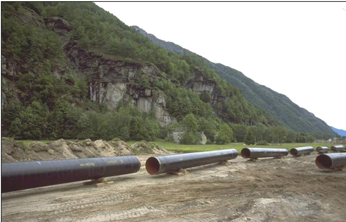
**Fig. 2.3/C: Sfilamento tubi**
