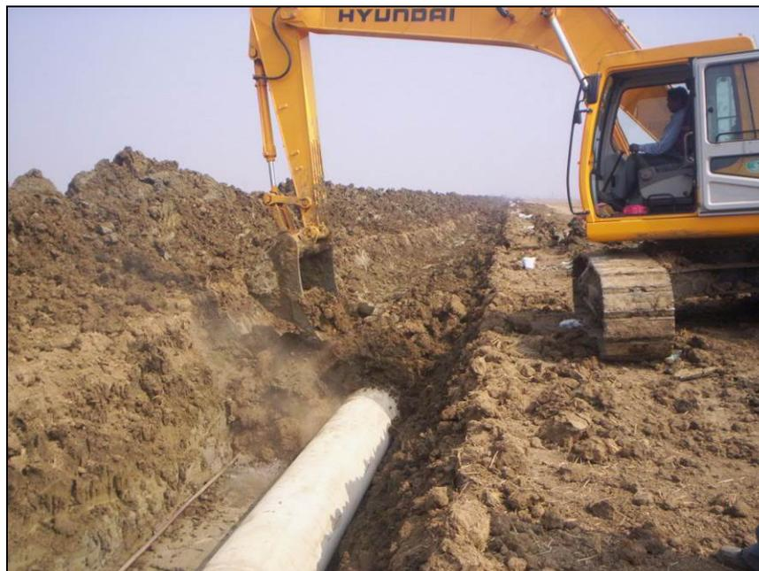
**Fig. 2.3/E: Rinterro della condotta**
