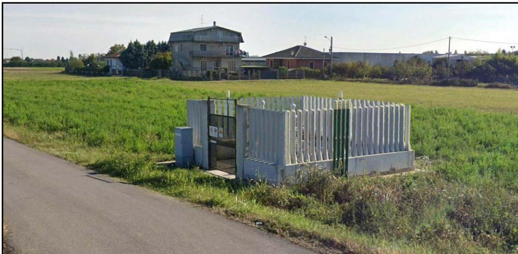
Fig. 2.3/J: Installazione tipo impianti di linea con recinzione in pannelli in cls prefabbricati
