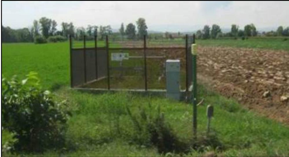
Fig. 2.3/I: Installazione tipo impianti di linea con pannelli in grigliato di ferro verniciato
