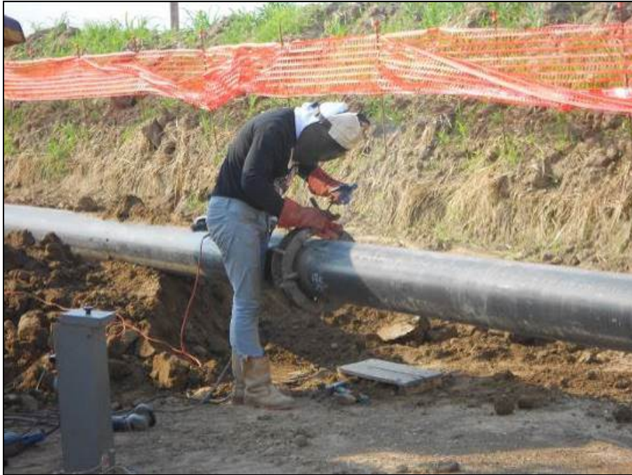
Fig. 5/D: Saldatura delle tubazioni
