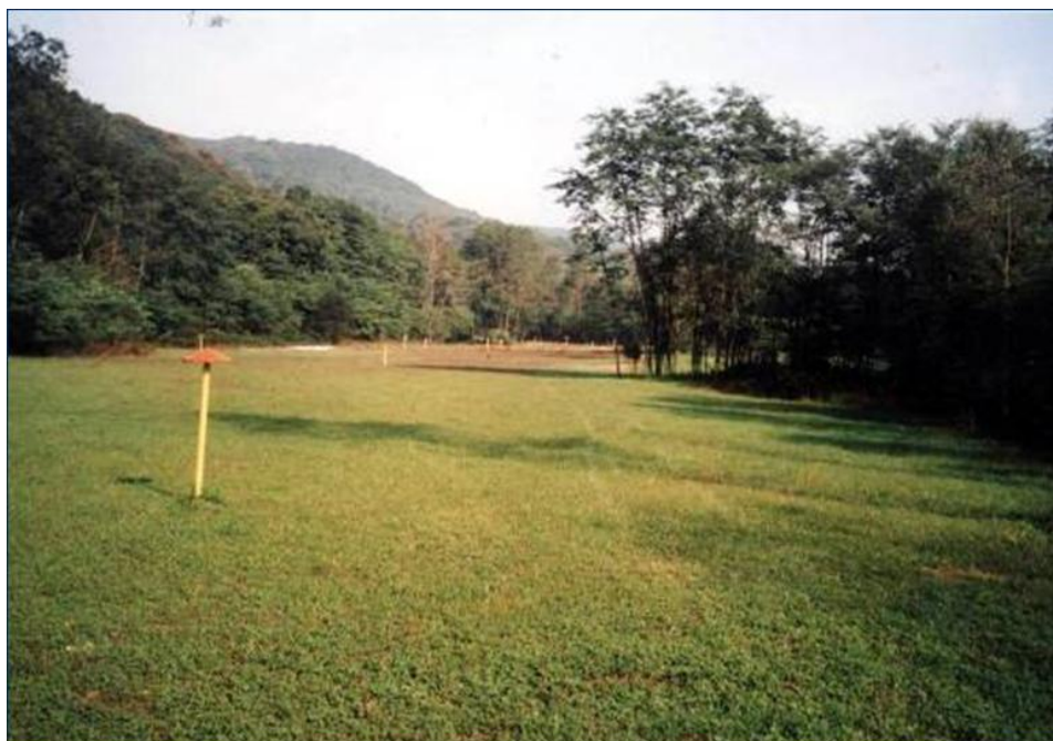
Fig. 5/K – Pista di lavoro ad opera ultimata su un gasdotto in esercizio
