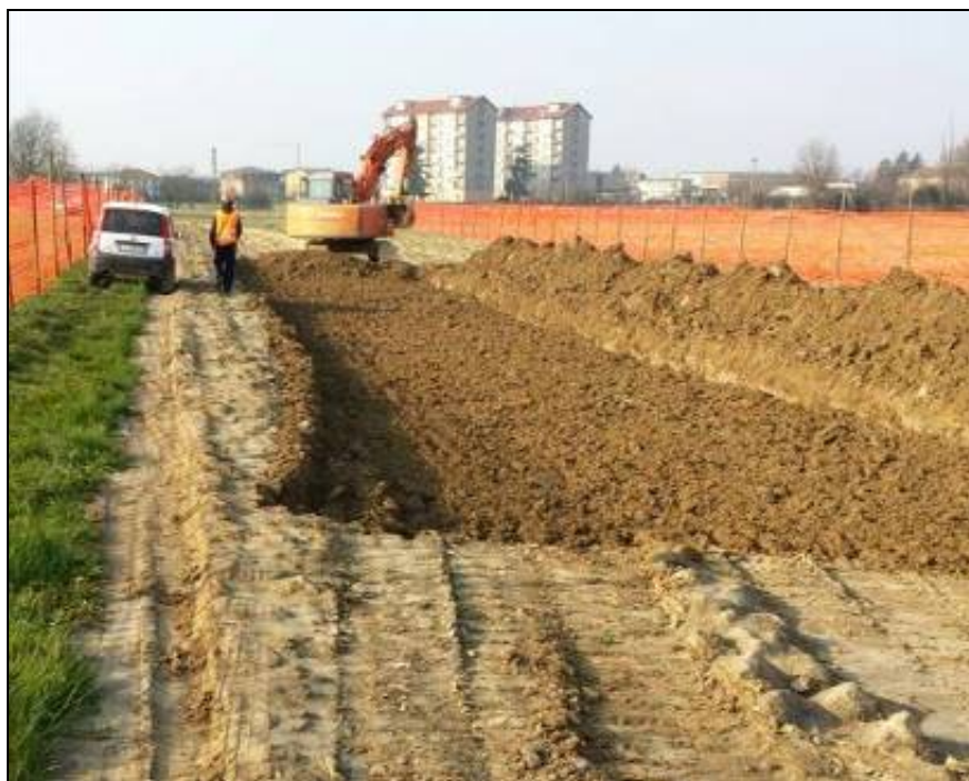
Fig. 5/B: Apertura della pista di lavoro
