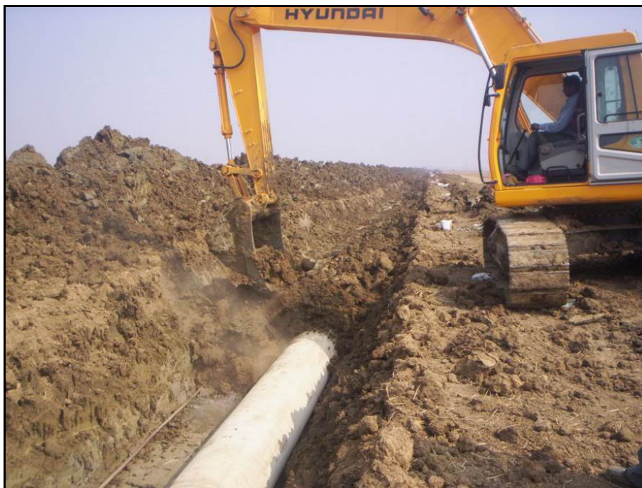
Fig. 5/H: Rinterro della condotta
