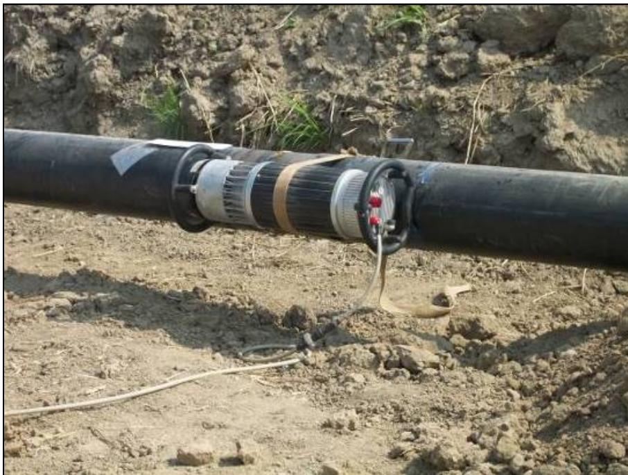
Fig. 5/E: Controlli non distruttivi delle saldature
