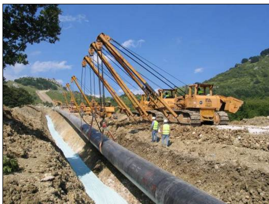
Fig. 5/G: Rinterro della condotta
