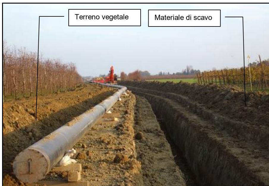
Fig. 5/F: Scavo della trincea
