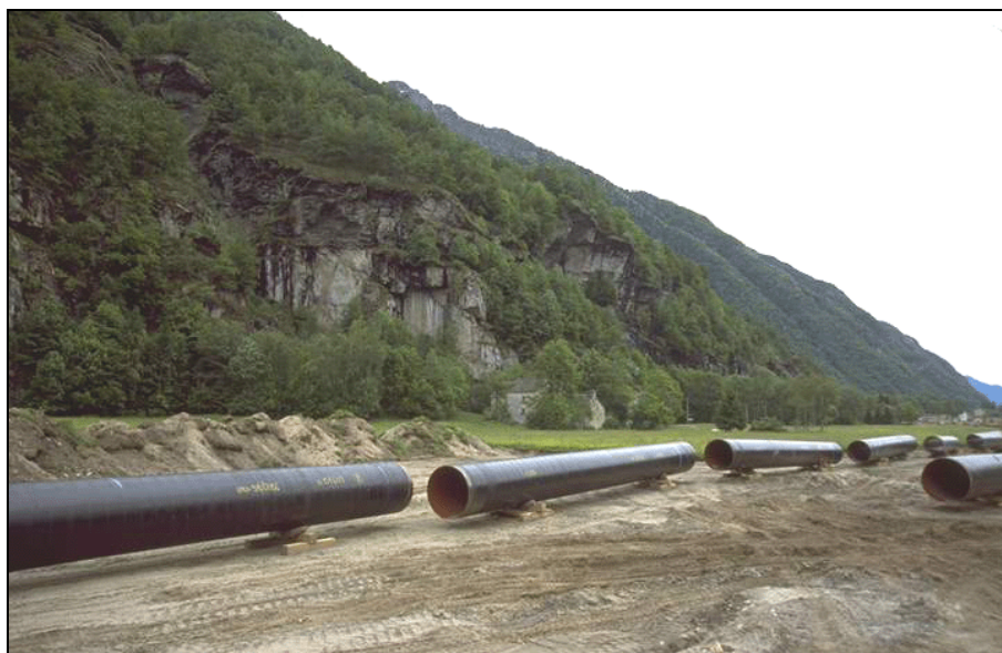
Fig. 5/C: Sfilamento tubi
