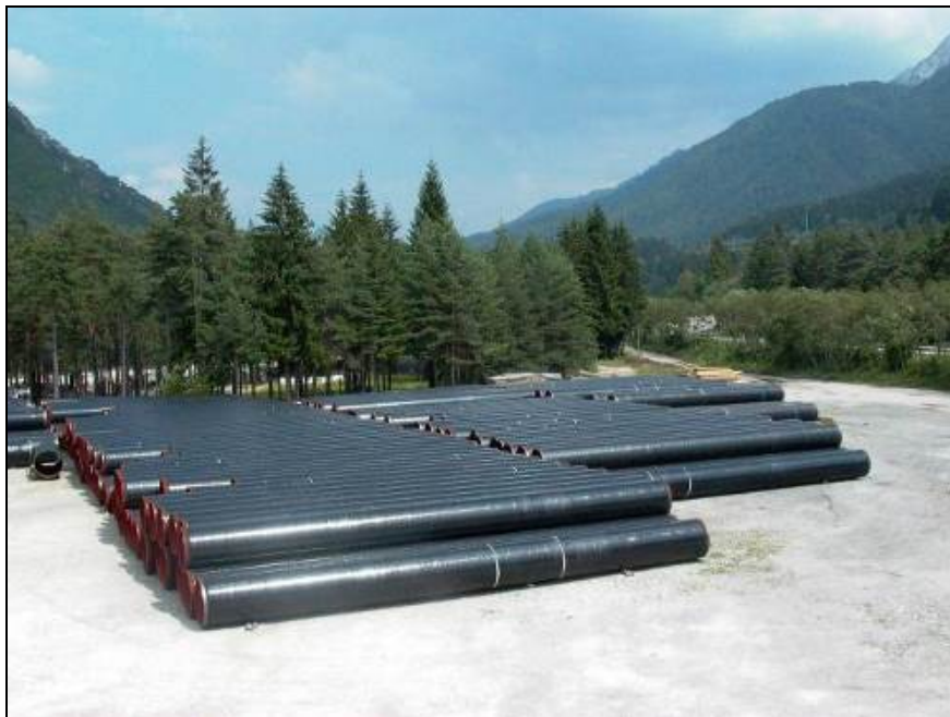
Fig. 5/A: Piazzola di accatastamento tubazioni
