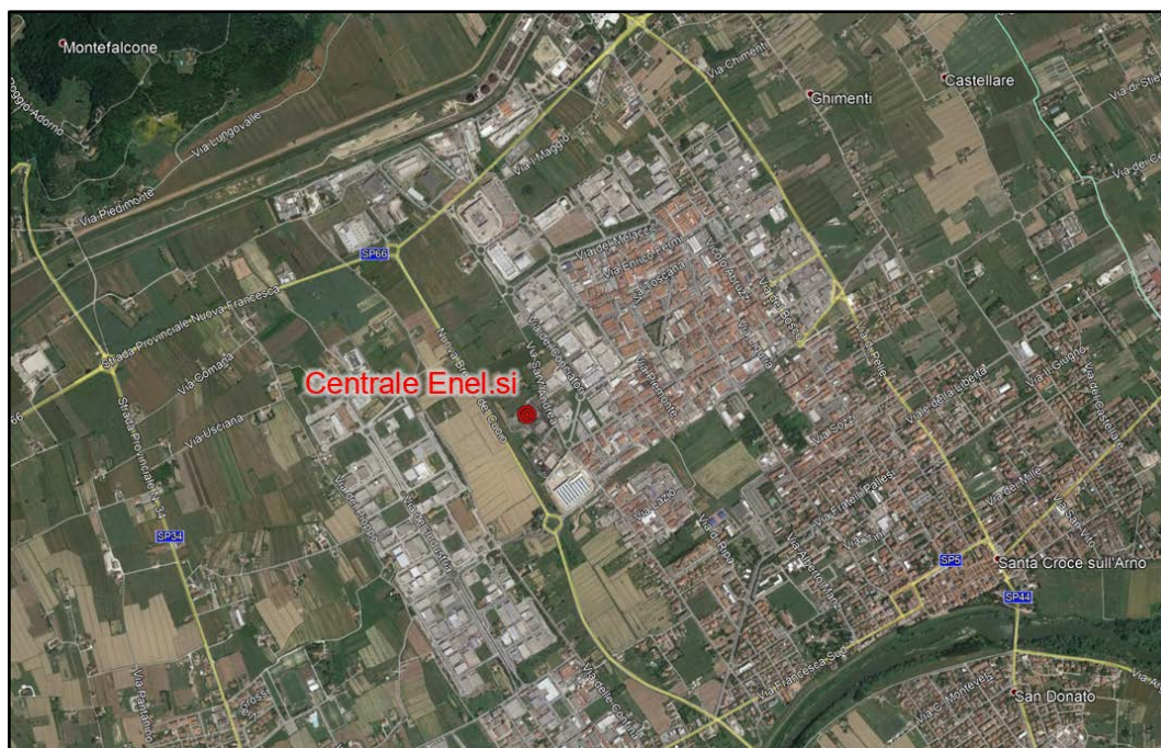
Figura 4a Vista aerea dell'impianto di cogenerazione: inquadramento generale
