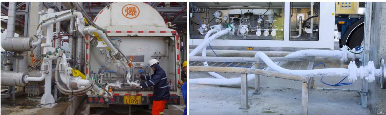
**Fig. 6.2** - esempi di bracci di carico (foto a sx) e tubi flessibili (foto a dx) per il riempimento delle autocisterne.
