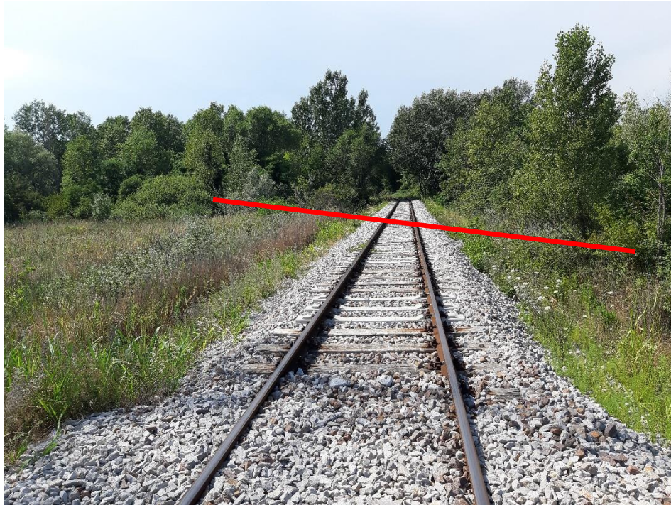
FOTO N.5 – Panoramica attraversamento raccordo ferroviario base All. Cartiera Burgo
