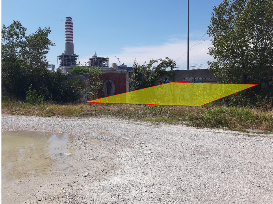
FOTO N.19 – Area prevista per la realizzazione del punto di consegna alla centrale A2A (all'interno della recinzione della centrale)
