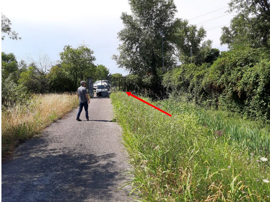
FOTO N.11 – Area a monte dell’attraversamento via Consiglio d’Europa e raccordo ferroviario base del Lisert (Il attraversamento) mediante unica trivellazione
