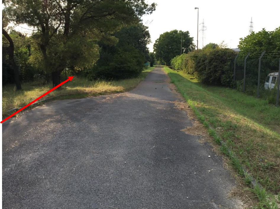
FOTO N.13 – Area a valle dell’attraversamento via Consiglio d’Europa e raccordo ferroviario base del Lisert (il attraversamento) mediante unica trivellazione
