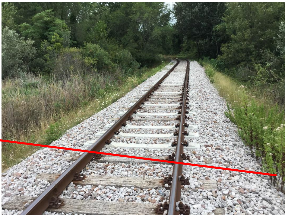
FOTO N.6 – Attraversamento raccordo ferroviario base All. Cartiera Burgo
