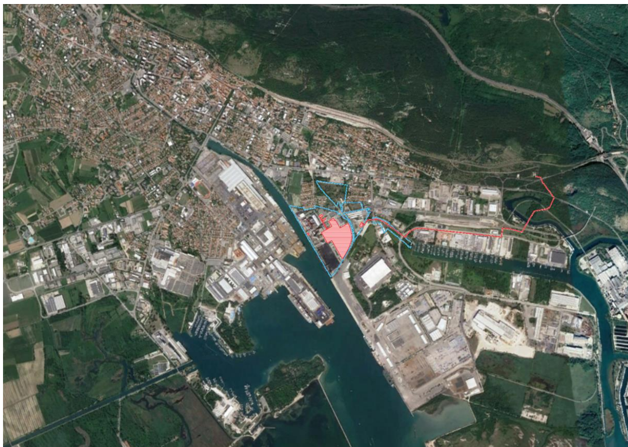
Figura 1-1: Ubicazione della Centrale Termoelettrica di Monfalcone
