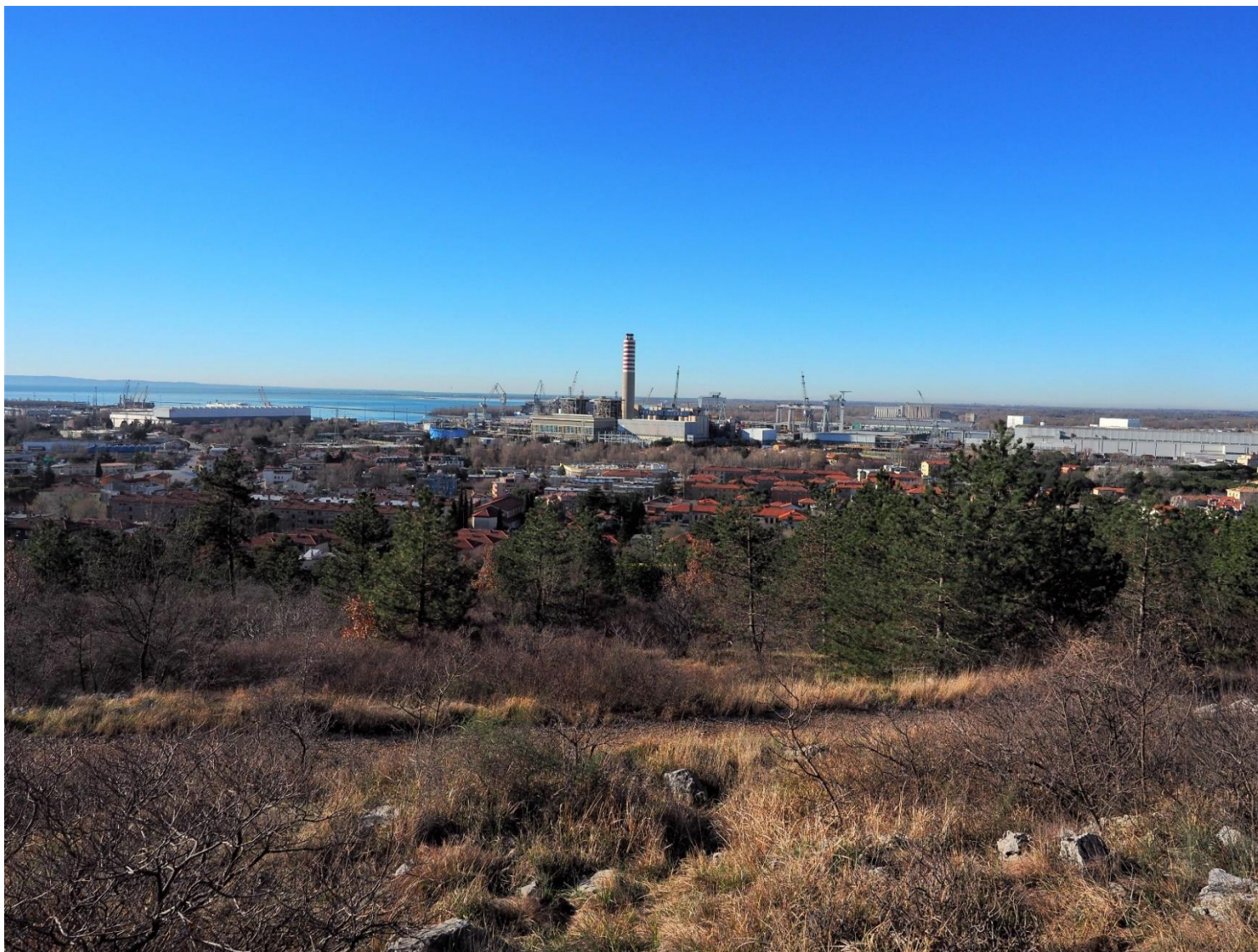
Figura 4-47: Panoramica della Centrale Termoelettrica dalle alture poste nella fascia orientale del territorio comunale di Monfalcone (la Centrale è riconoscibile per la presenza del camino)
