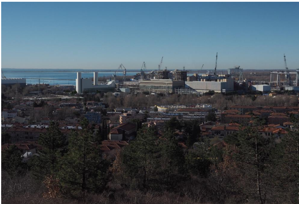
Figura 21: Fotoinserimento PV1 – situazione futura dopo l’abbattimento del camino esistente
