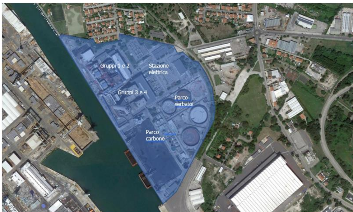
Figura 6.1-1: Immagine aerea (2015) dell'area occupata dalla Centrale Termoelettrica esistente
