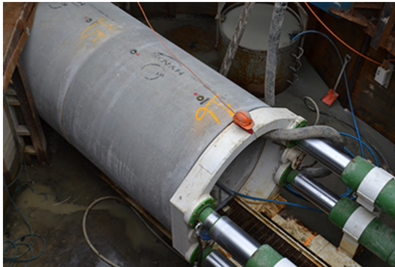
Figura 2.18 Esempio unità di spinta con pistoni idraulici
