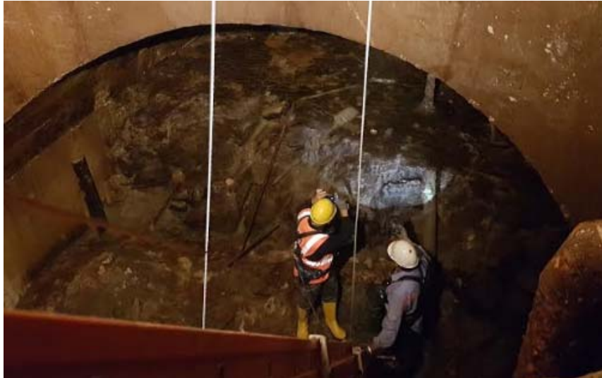
Figura 10 – Fronte di scavo attuale del tratto di galleria di scarico
